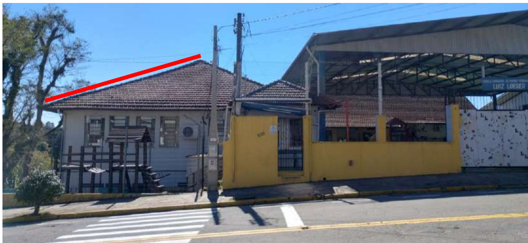
Foto 3 – Vista do telhado em questão, sendo as fotos seguintes referentes ao trecho à esquerda da cobertura metálica.
