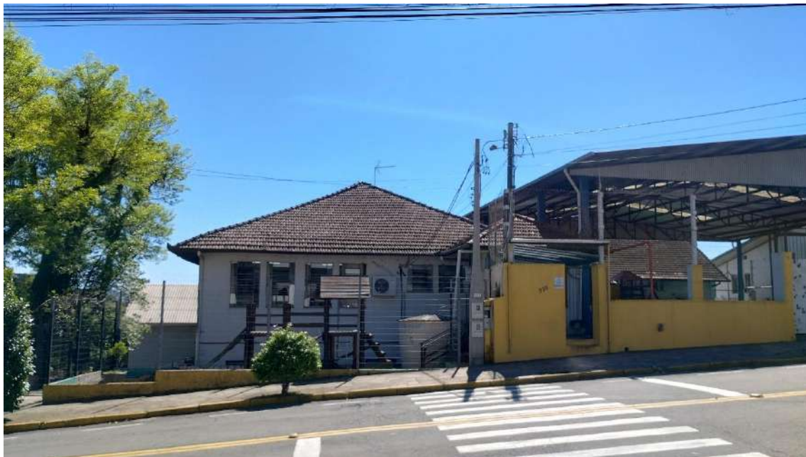
Imagem 01 – Vista frontal do prédio a restaurar o telhado
