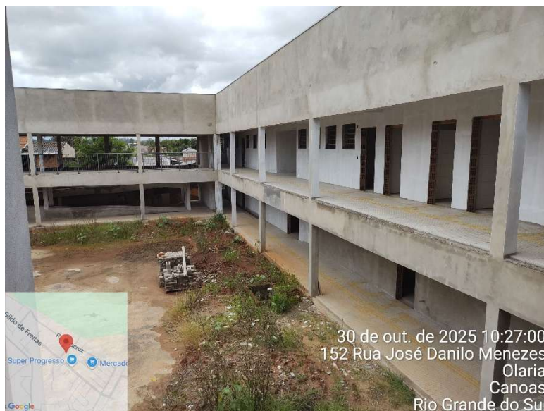
8. Vista geral do bloco cozinha / refeitório e ao fundo o bloco da rampa e sanitários
