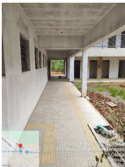
10. circulação do térreo – bloco biblioteca / salas de aula
