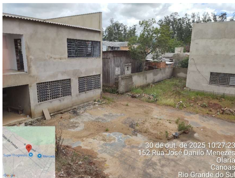
7. Vista geral do pátio aberto, bloco administrativo e bloco biblioteca
