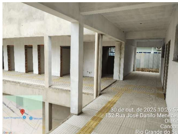
24. Vista da circulação pavimento superior – bloco administrativo
