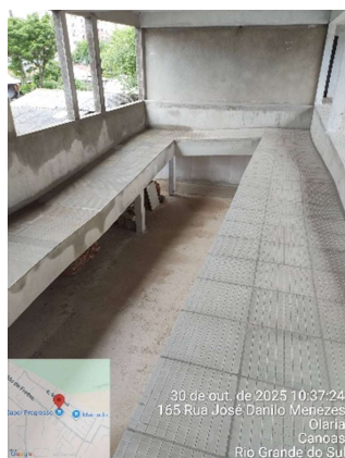
27. Vista da rampa
