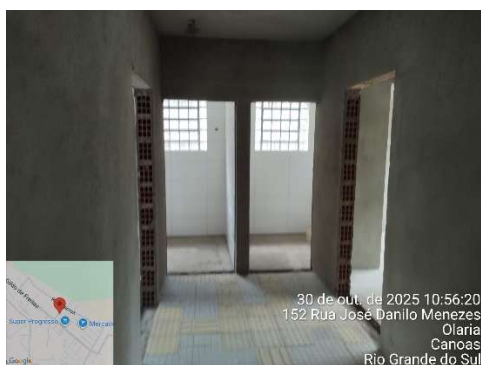
13. circulação bloco administrativo ao fundo sanitário
