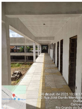
23. Vista da circulação pavimento superior – bloco cozinha / refeitório / salas de aula
