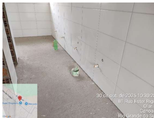
26. Vista interna dos sanitários
