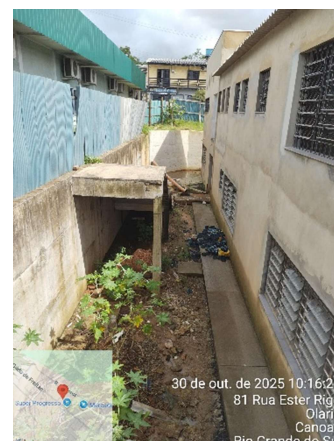
22. Vista externa do muro de contenção existente
