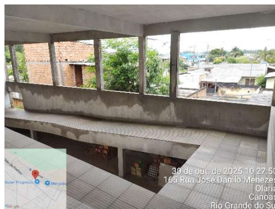
28. Vista da rampa
