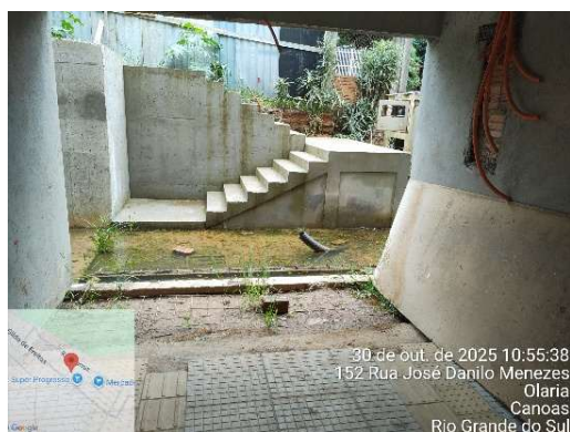
18. Vista do saguão e escada externa 1
