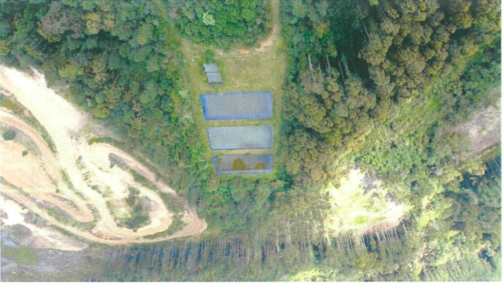
Foto 4. Vista aérea geral das 4 estruturas, sendo que três serão desativadas.
