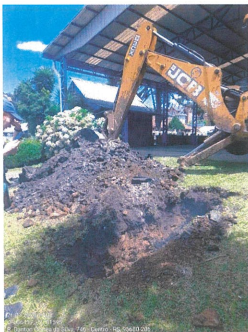
Figura 2. Execução do FS1.
