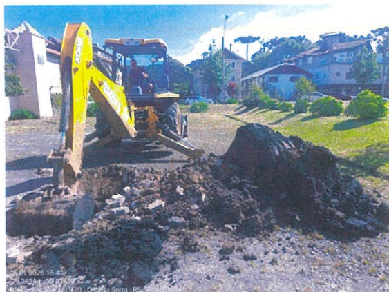
Figura 8. Execução do FS3.
