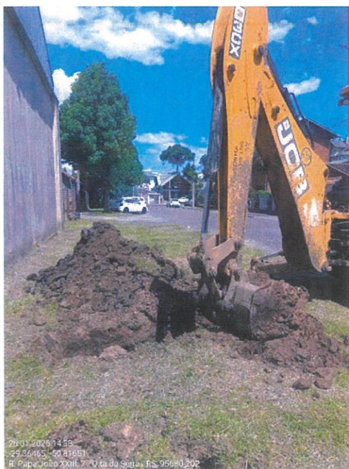
Figura 5. Execução do FS2.
