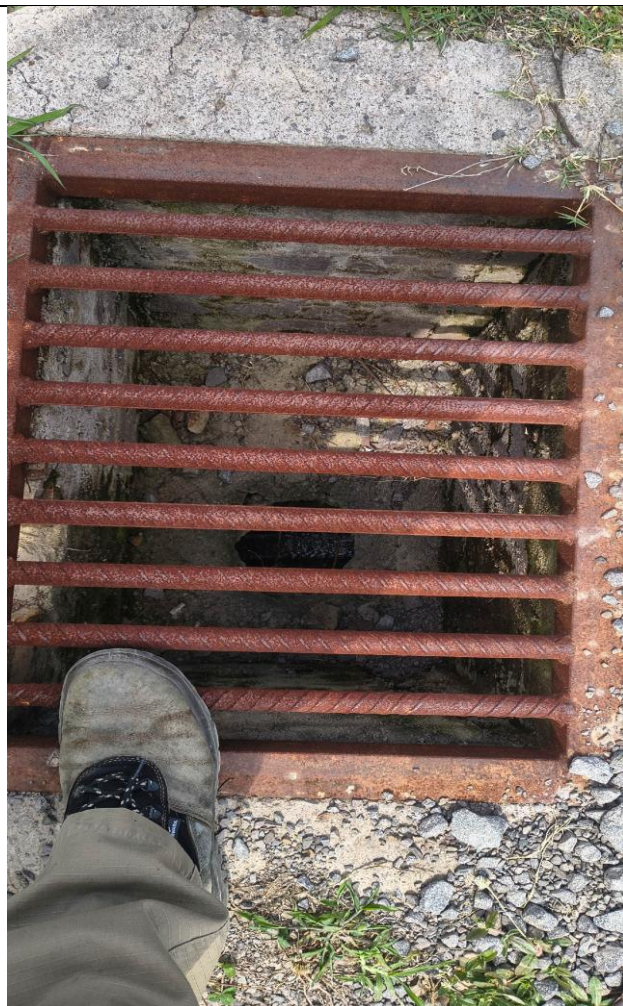
Imagem 02 – Caixas de drenagem existente
