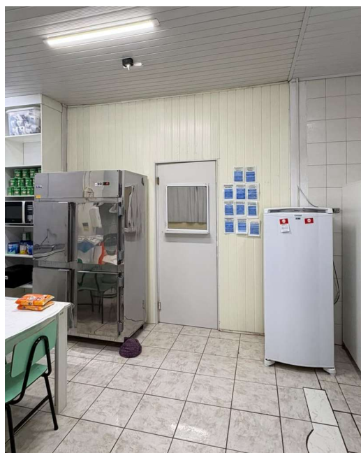
Imagem 2 – Parede de PVC existente na cozinha a ser substituída
