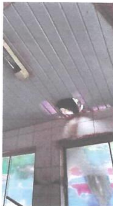
Foto 2 — Outro ponto de reparo do forro.
