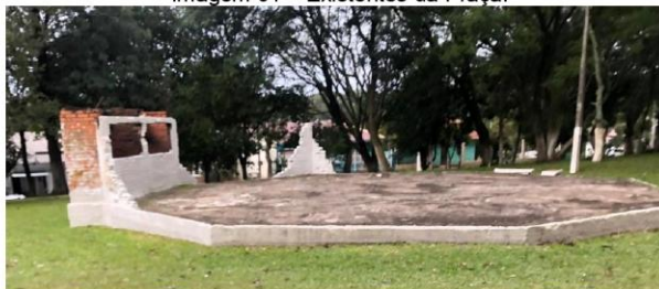
Imagem 01 – Existentes da Praça.
