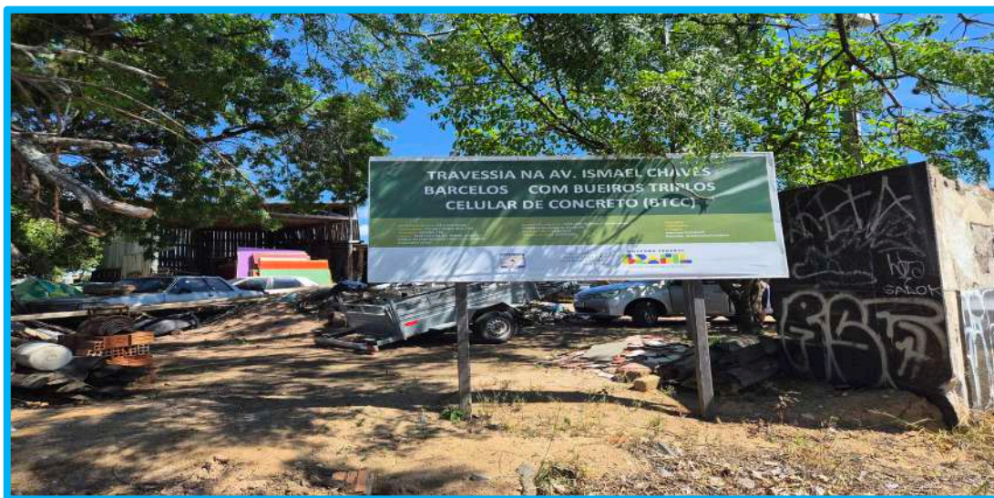
Figura 17- Bueiro BTCC executado (fonte própria)
