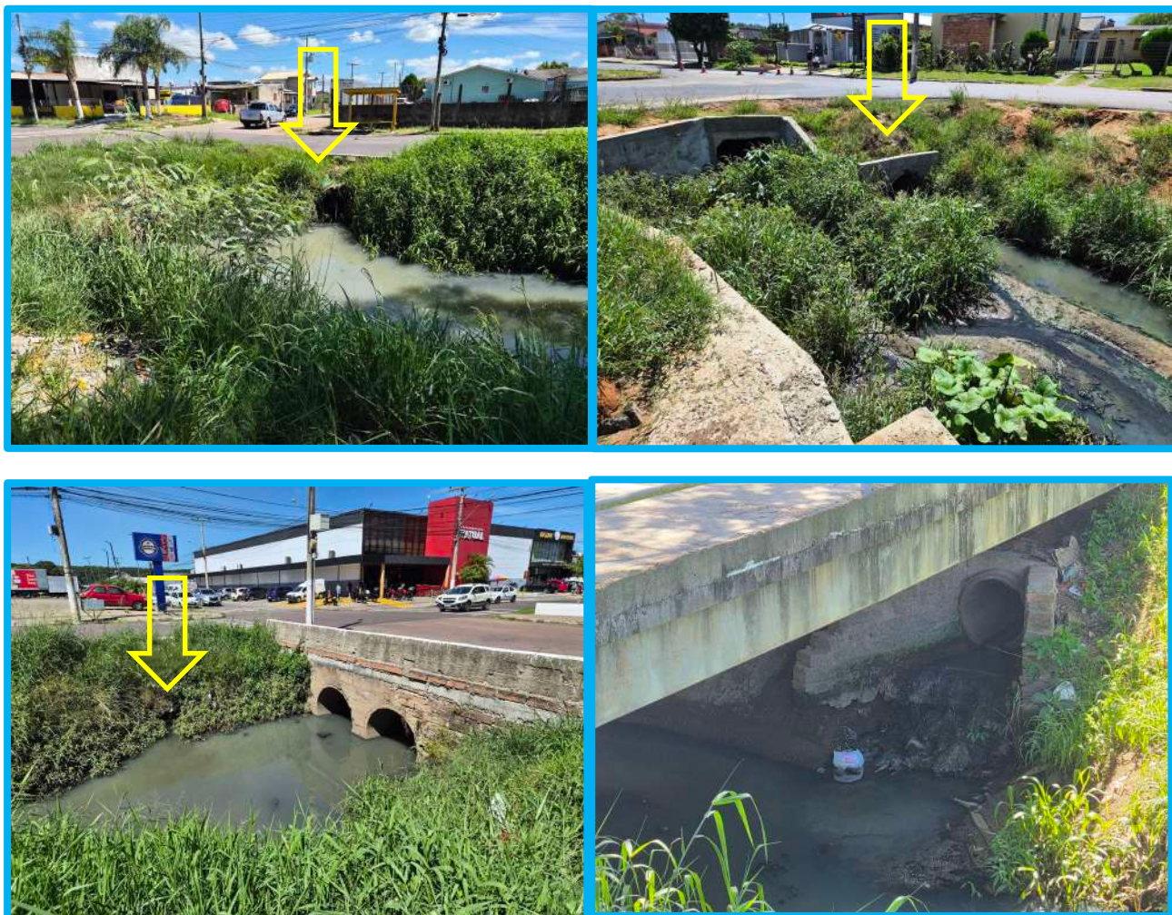
Figura 35 - Exutório no canal central das Ruas perpendiculares a Canal Cohab/Santa Rita
