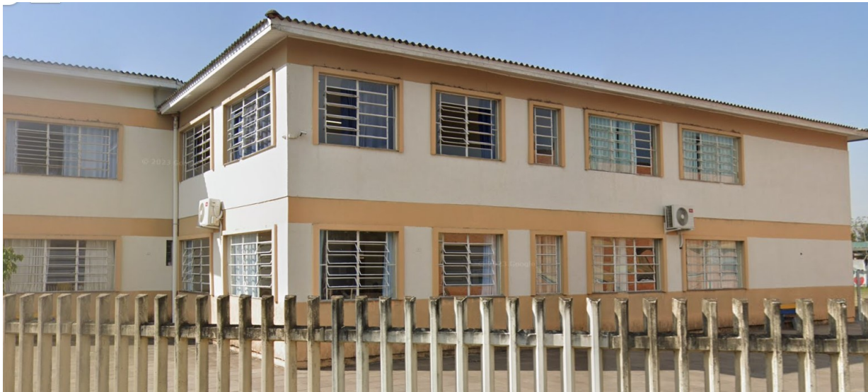
Exemplo de janelas que deverão ser removidas
