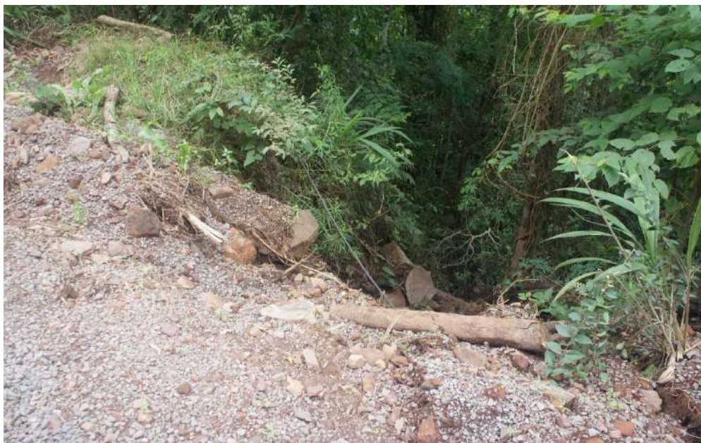
Figura 7: Sulgo erosivo de bordo identificado na estaca km 2+720.
