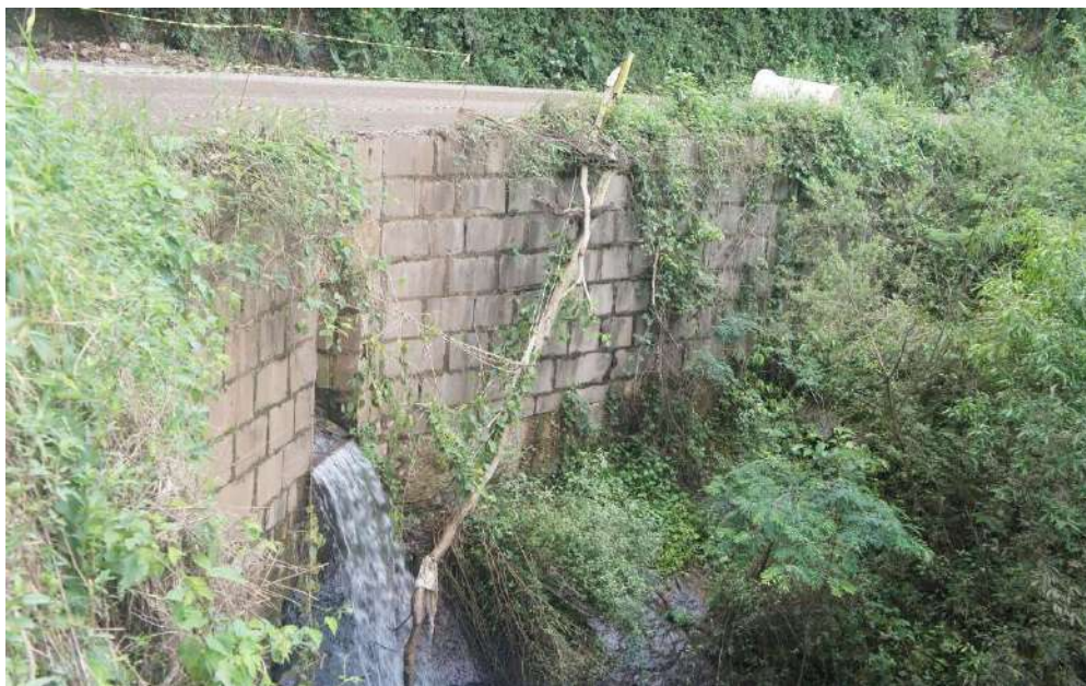
Figura 26: Segmento de muro em pedra argamassada, identificado na estaca km 1+480.
