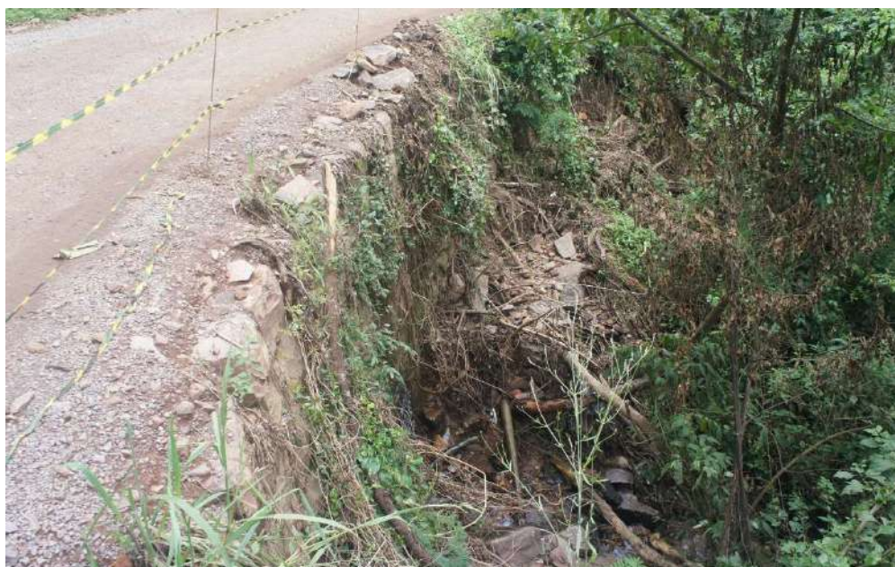
Figura 25: Segmento de muro em pedra colocada identificado na estaca km 1+020.
