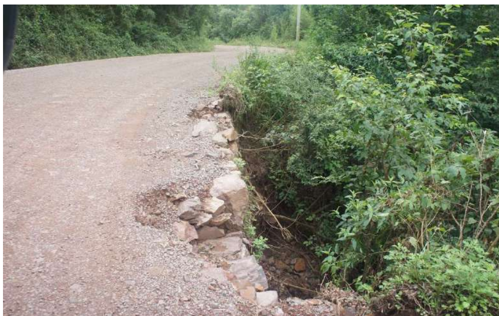
Figura 24: Segmento de muro em pedra colocada identificado na estaca km 0+500.
