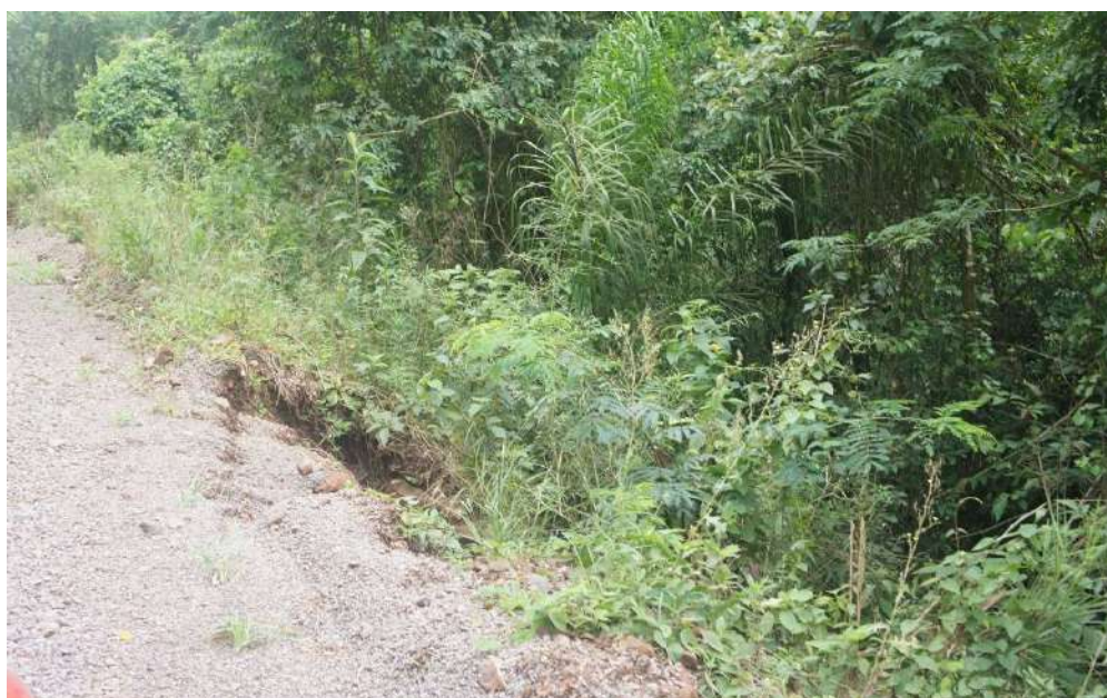
Figura 10: Erosão de bordo identificada na estaca km 3+100.
