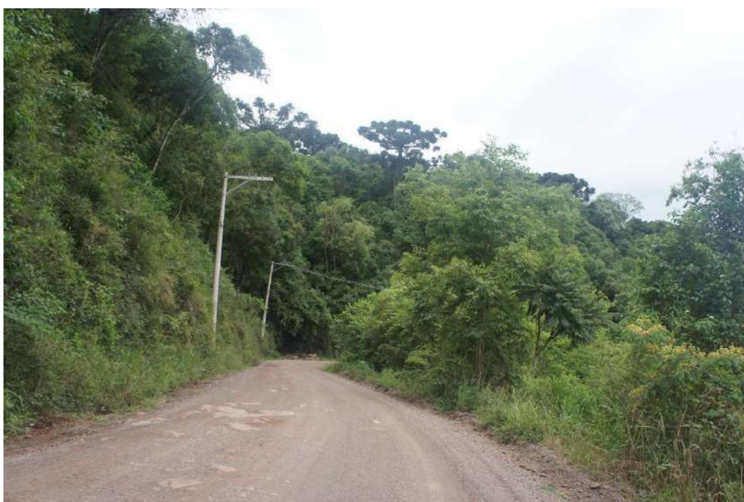
Figura 1: Encosta (LD) e o leito do trecho existente.
