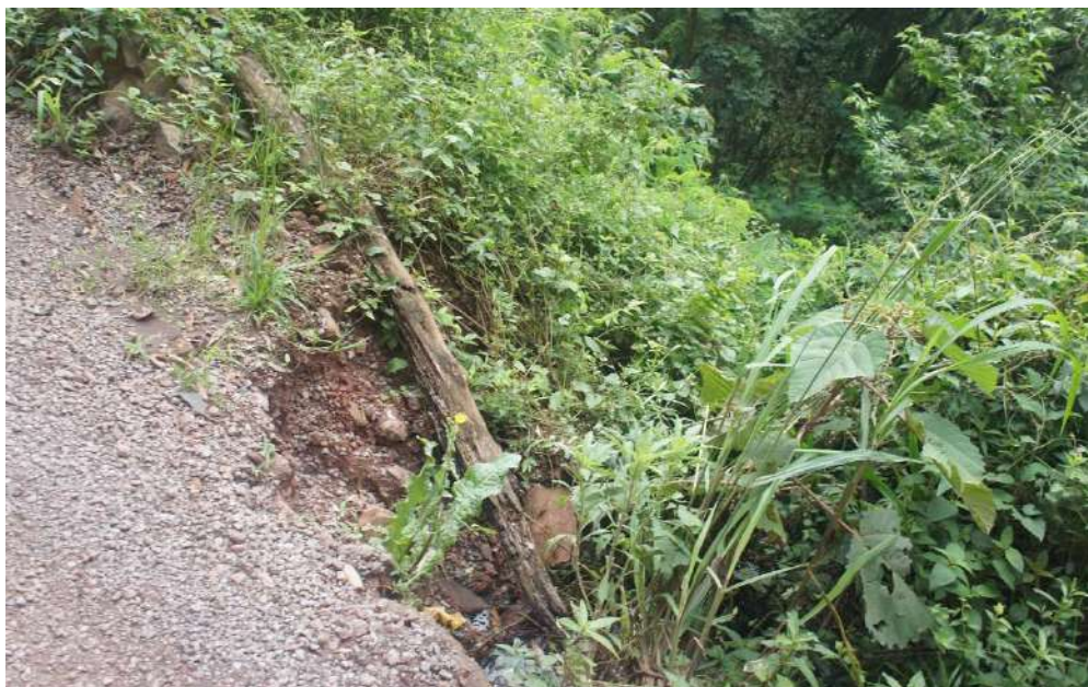
Figura 3: Sulgo erosivo identificado na estaca km 1+740, no bordo da pista.
