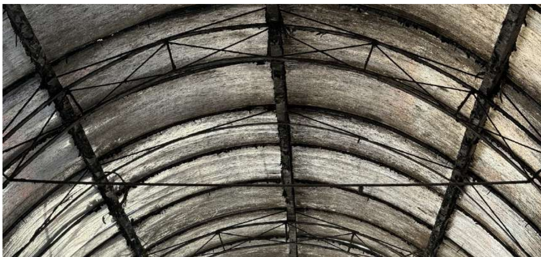
Foto 08 — Detalhe da cobertura e dos perfis metálicos aparentes
