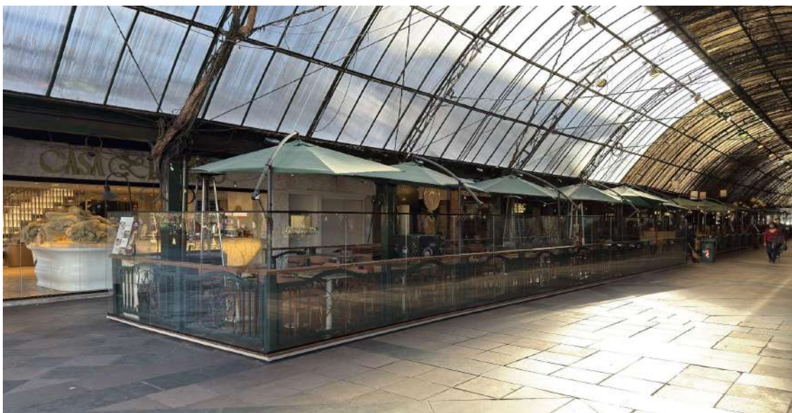
Foto 28 — Vista de módulo comercial e avanço de estruturas delimitadoras
