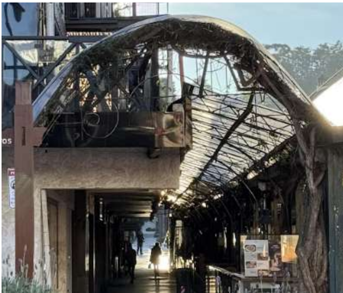
Foto 02 — Vista geral da Rua Coberta no sentido Borges de Medeiros → Garibaldi
