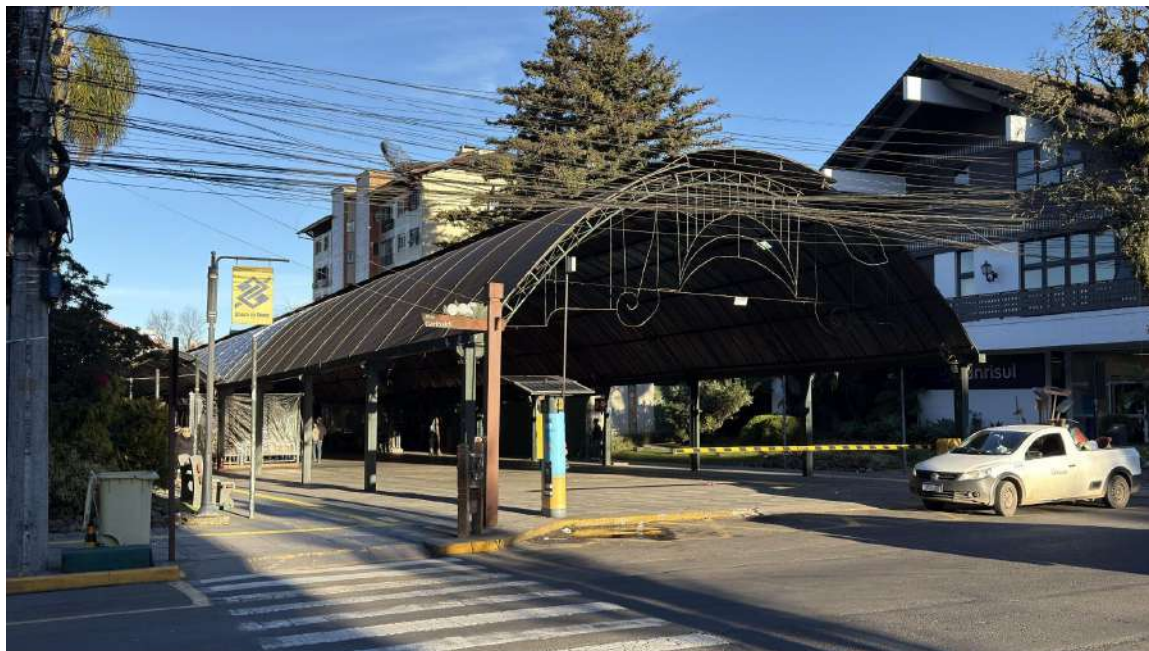
Foto 31 — Vista externa do acesso e interferência de cabeamento aéreo no entorno
