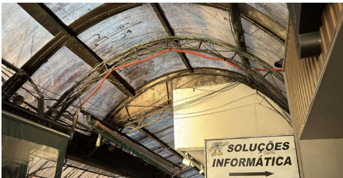
Foto 23 — Cabeamentos e tubulação aparentes sob a cobertura
