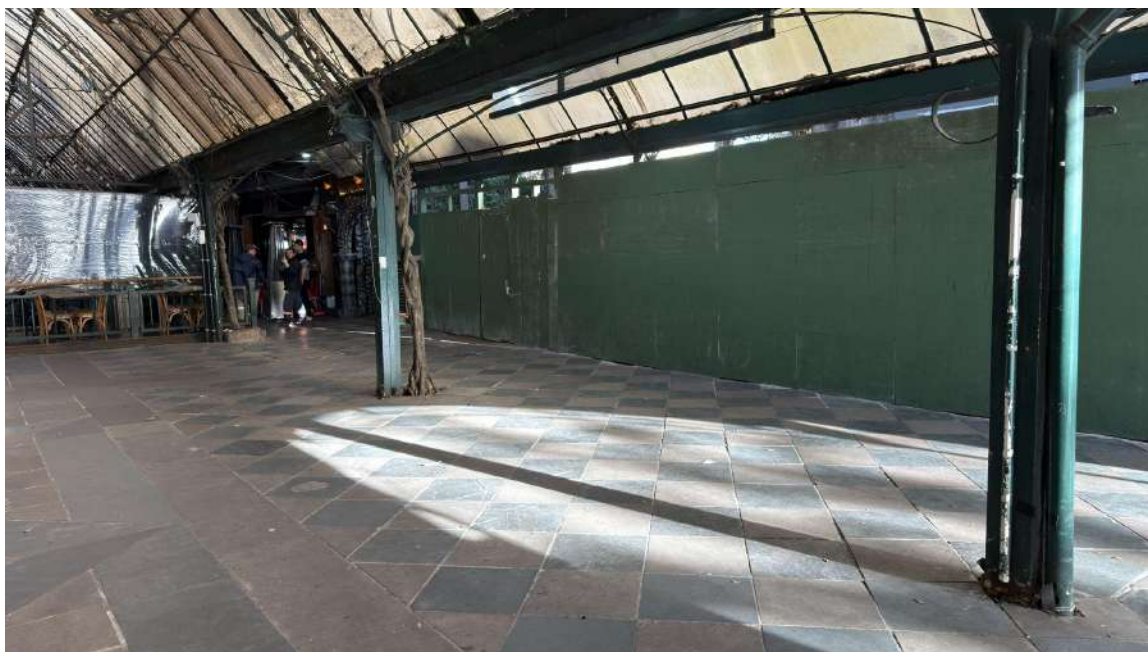
Foto 09 — Vista de conjunto do alinhamento de pilares laterais
