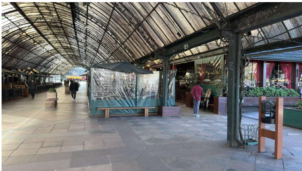
Foto 29 — Fechamentos verticais flexíveis e despadronização dos módulos
