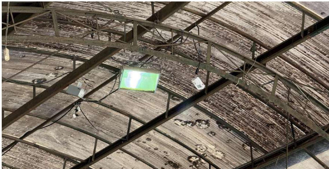
Foto 05 — Detalhe inferior dos arcos estruturais e placas da cobertura
