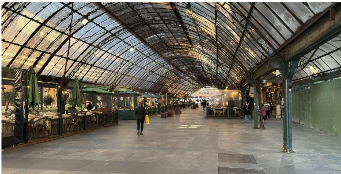
Foto 03 — Vista longitudinal interna do eixo de circulação
