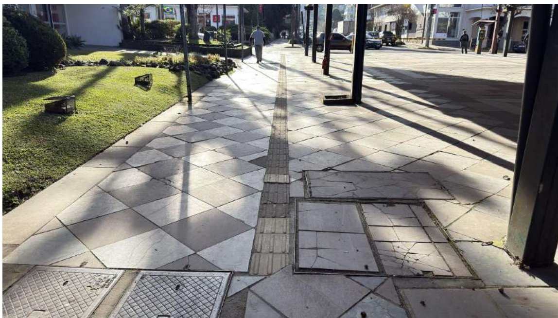
Foto 13 — Registro de pavimentação externa e rotas de acessibilidade
