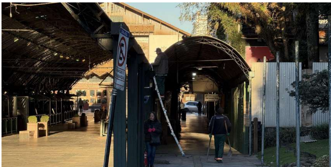
Foto 27 — Interface da Rua Coberta com edificações lindeiras, em frente ao nº 113
