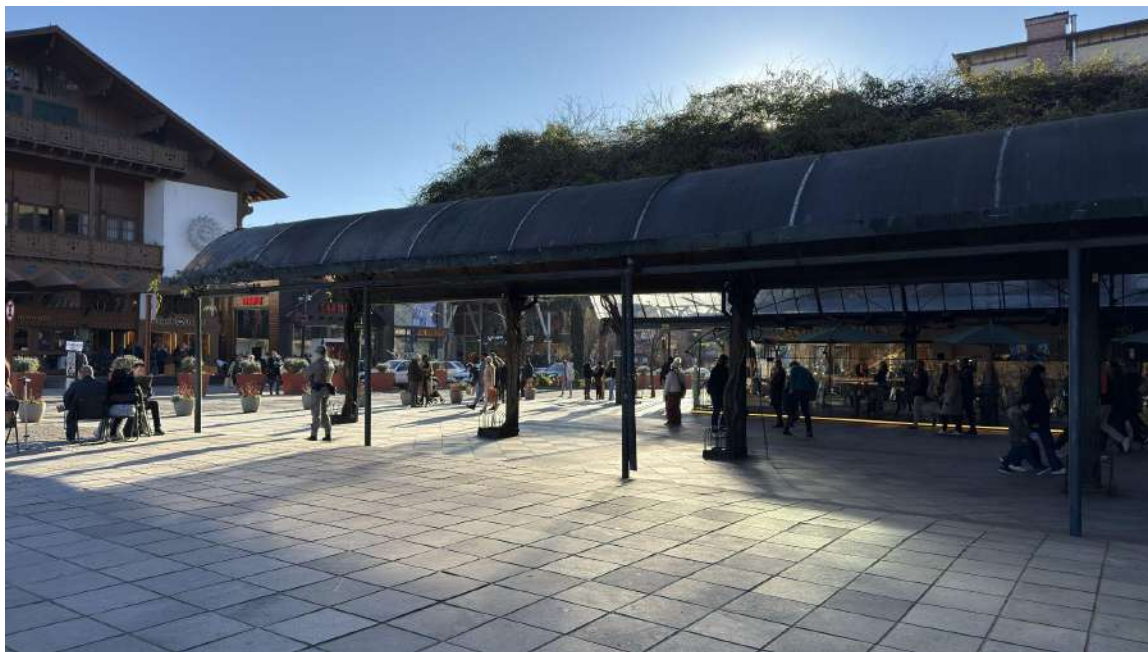
Foto 32 — Zona de transição com a praça pública e desgaste na cobertura secundária
