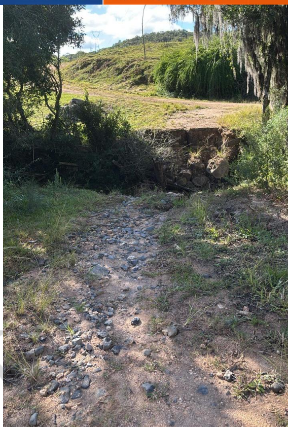
Figura 2 – Vista geral do local da travessia.
