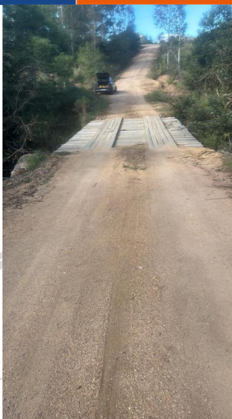
Figura 2 – Vista geral do local da travessia.
