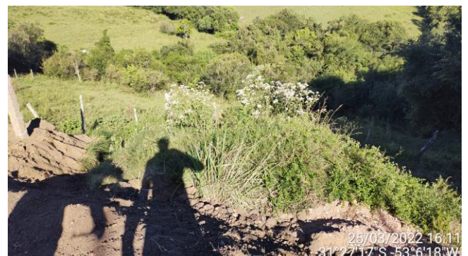
Figura 10 – Rua Inácio Lopes Guterres Estaca 4;
