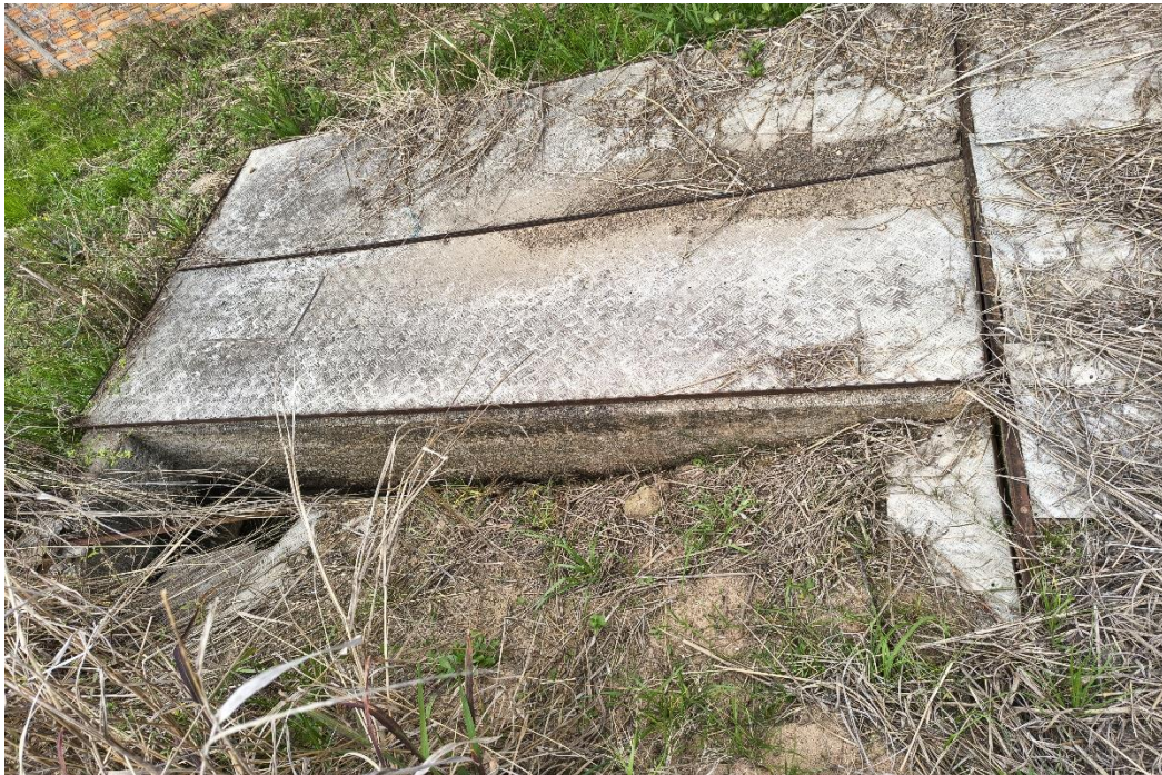
Área de lavagem de veículos, CSAO tampa danificada e disposição irregular de resíduos ao redor da rampa
