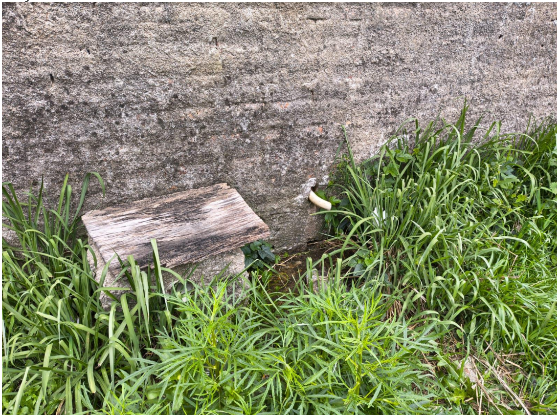
Instalações hidrossanitárias com esgoto doméstico/efluente doméstico lançados direto ao solo:
