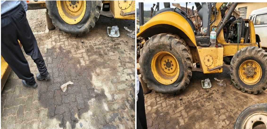
Parte externa da área de manutenção- piso sem impermeabilização e com vazamento de óleo;
