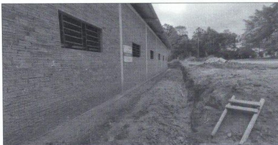
Figura 1 - Local de execução do dreno
