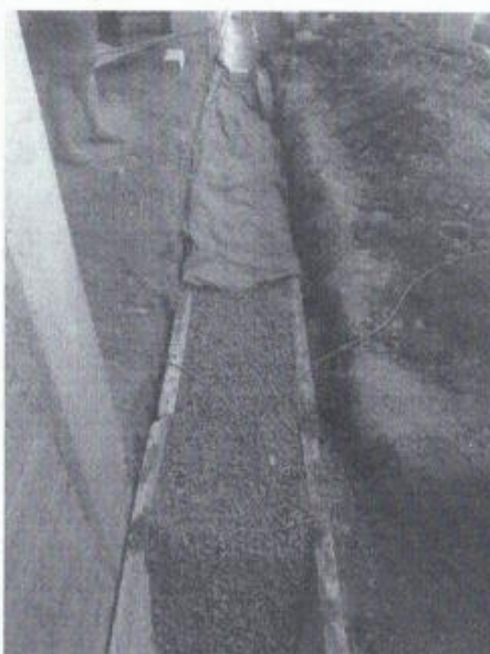
Figura 3 - Preenchimento com brita
