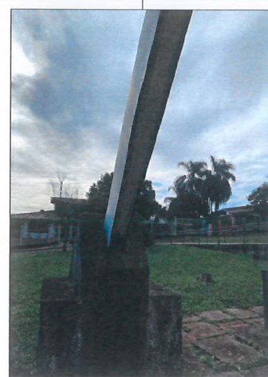
Revitalização das algeroz metalicas
