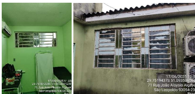
Figura 8 - Exemplo de esquadrias a serem lixadas e pintadas
