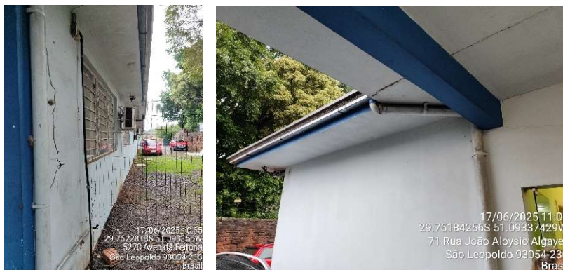
Figura 13 - Exemplos de refletores externos a serem substituídos
