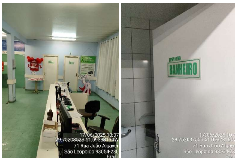
Figura 11 - Sanitários a ter parede de Drywall executadas a fim de ampliação Fonte: DEPRO, 2025
