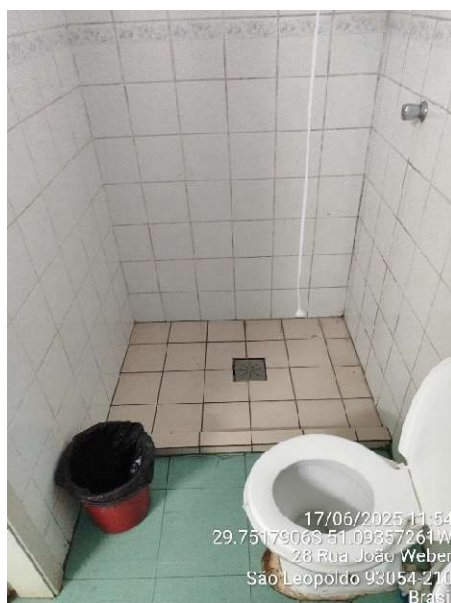
Figura 4 – Mureta de alvenaria que deverá ser removida
