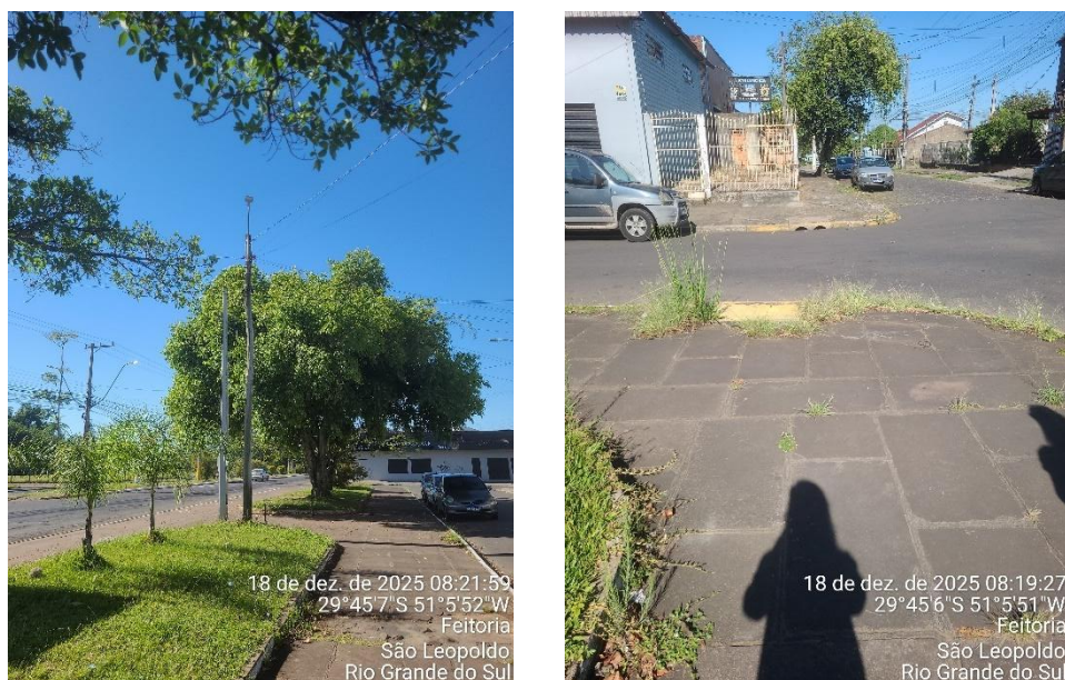
Figura 1 - a) poste com cabos a serem removidos e b) calçada de pedra grês a ser removida
