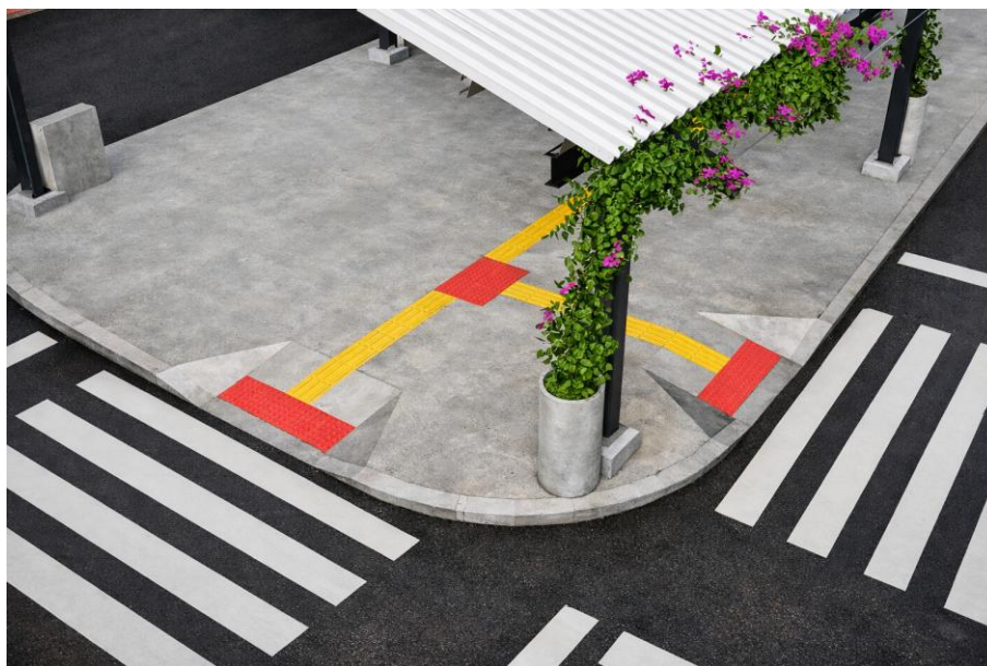
Figura 4 - Rampas de acessibilidade e piso podotátil
