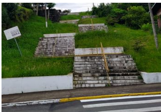
Figura 3 – Situação atual da escadaria.
