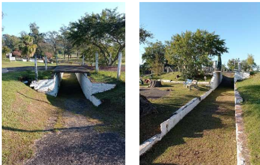
Imagens do túnel atualmente
