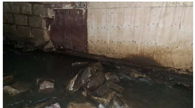
Foto 27 - base da parede de concreto
