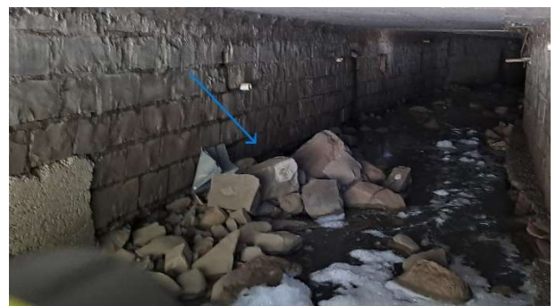
Foto 6 - Blocos originários da Estrutura
