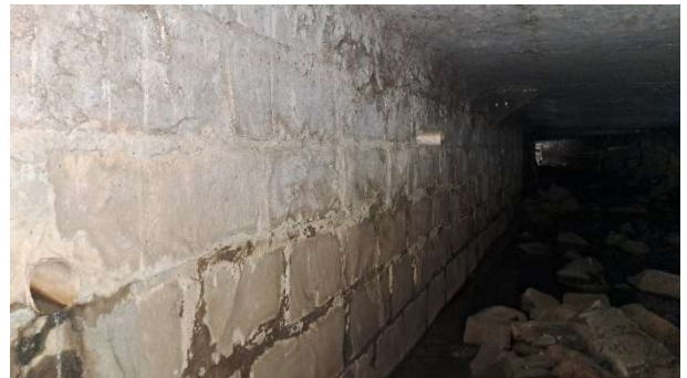
Foto 13 - Drenos na parede leste
