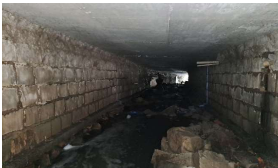
Foto 32 - Visão geral da galeria próximo a abertura lateral
