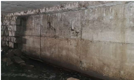
Foto 31 - Parede de concreto face oeste
