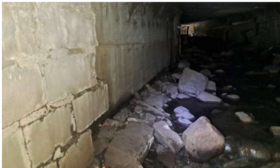
Foto 16 - Paredes de concreto na parede leste
