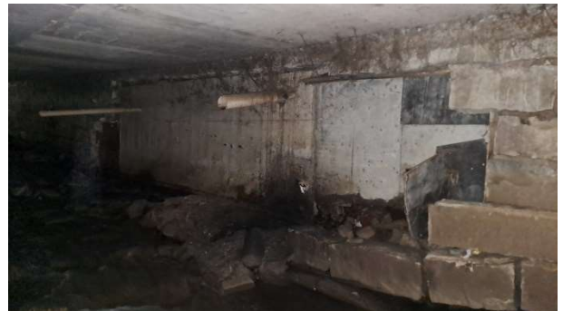
Foto 26 - Parede de concreto na face oeste
