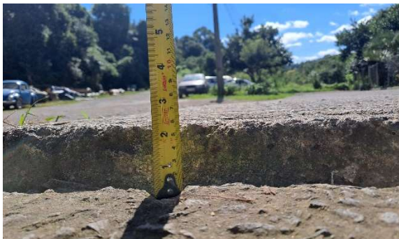
Foto 3 - Rebaixo da laje de cobertura
