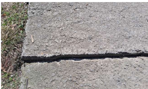
Foto 4 - Rebaixo da laje de cobertura
