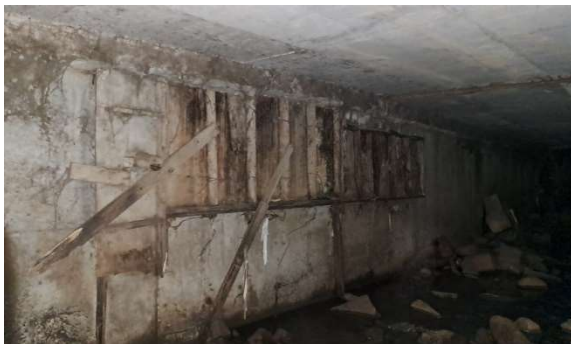
Foto 23 - Parede de concreto lado leste
