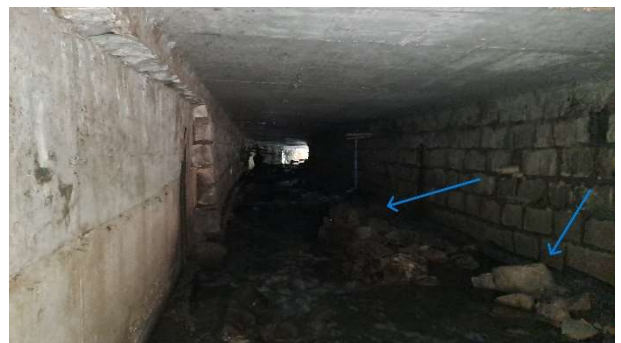
Foto 37 - Deposição das pedras da parede que cedeu e parede de concreto
