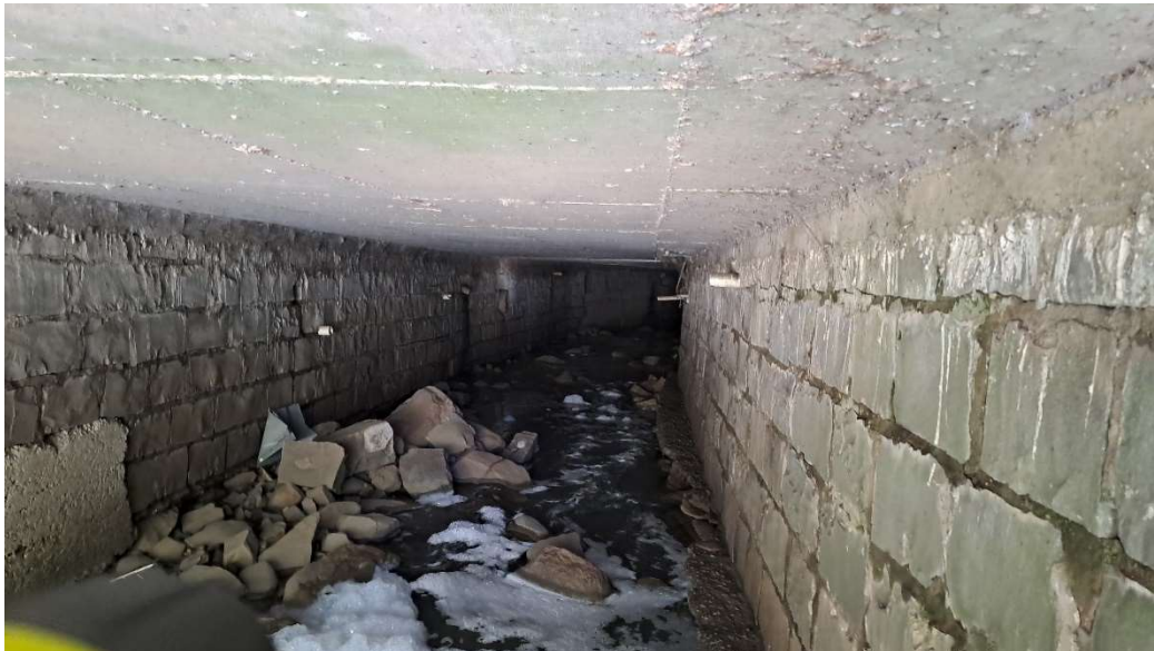
Figura 1- Visão geral da galeria em análise
