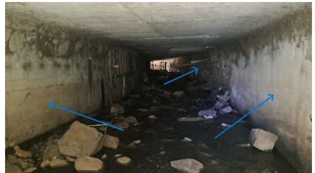
Foto 19 - Paredes de concreto
