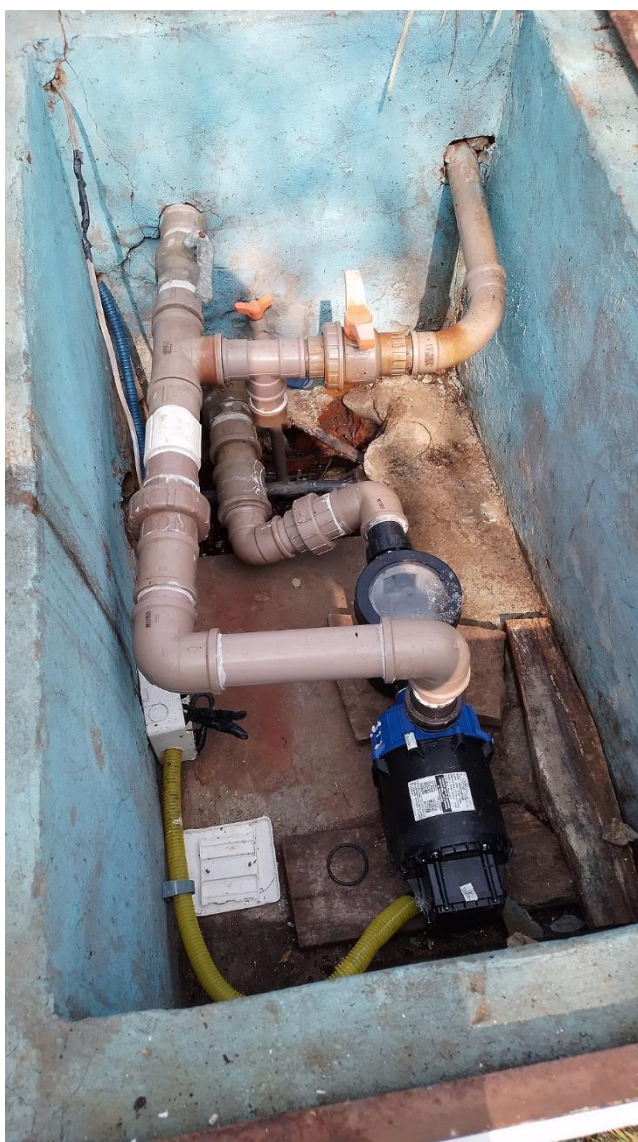
Imagem 1 - Casa de bombas existente
