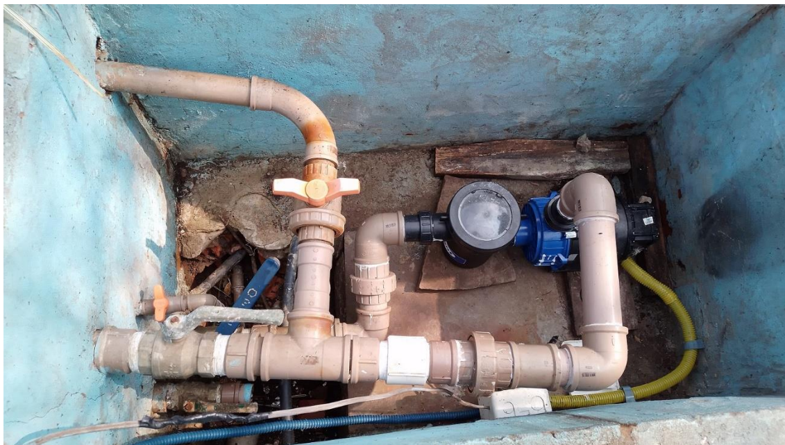
Imagem 2 - Casa de bombas existente
