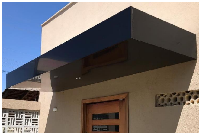
Figura 11 - Marquise em ACM na cor preta
