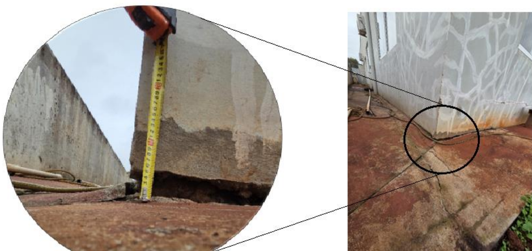
Figura 4 - Recalque diferencial
