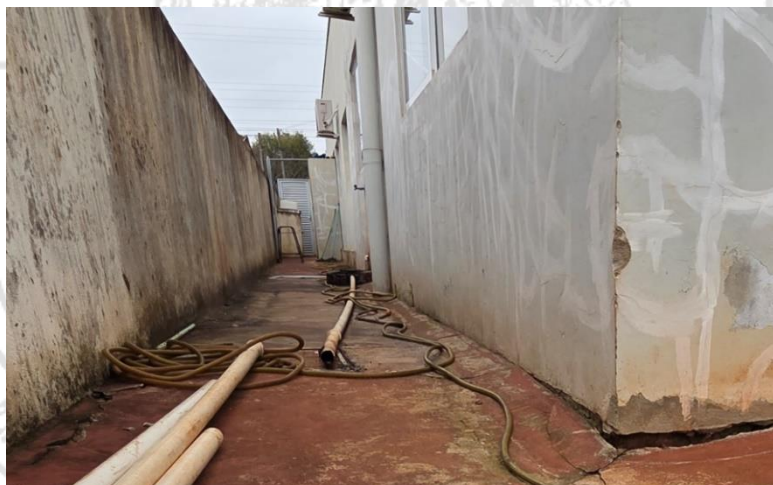
Figura 7 - Calçada a ser demolida e refeita tubulação de esgoto
