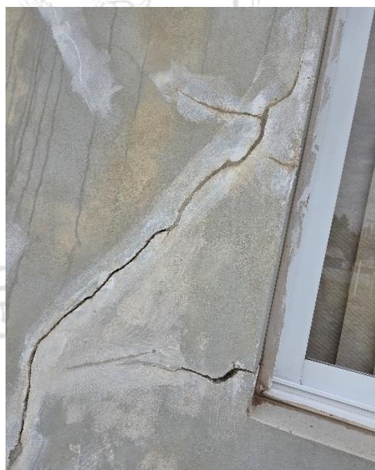
Figura 2 -Trinca janela CAD/ÚNICO
