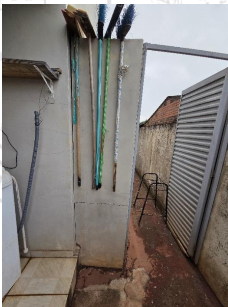
Figura 6 - Muro a ser demolido
