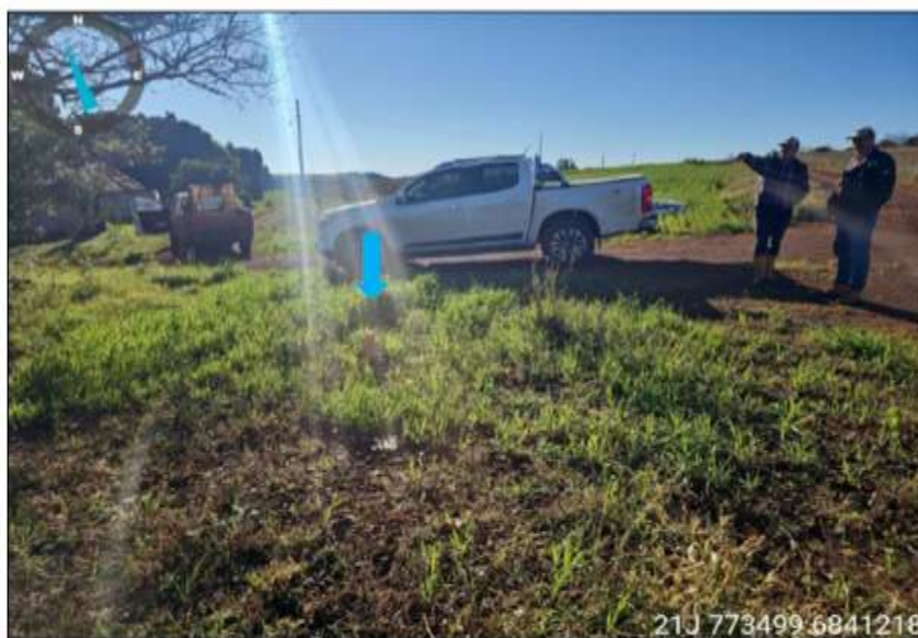
Figura 04. Área onde será realizada a perfuração do poço. Pode ser observada a existência de rede de energia próxima.
