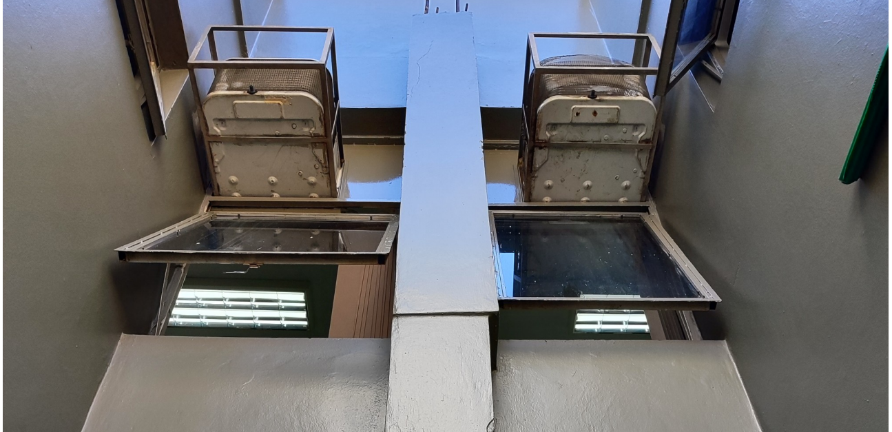
Figura 5: Acesso externo aos ares-condicionados das salas das bancadas do PDT e PP.
