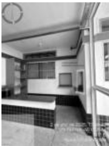
Figura 38: Passa-prato que será demolido para instalação de porta
