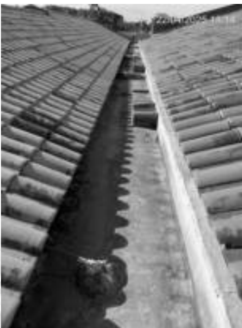
Figura 7: calha em concreto que terá instalação de calha em alumínio
