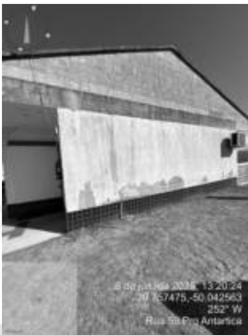
Figura 17: pastilhas já removidas
