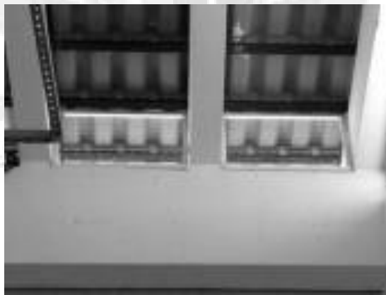
Figura 10: Modelo semelhante ao quadro telado para proteção da entrada de pássaros
