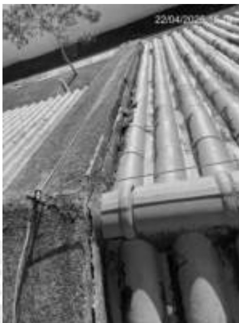
Figura 11: rufo em concreto com enchimento
