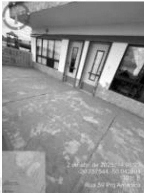
Figura 20: Laje dos solários que serão demolidas e reconstruídas
