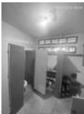
Figura 33: vestiário que irá se transformar em brinquedoteca
