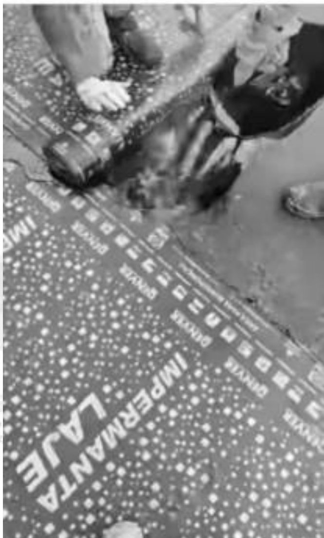
Figura 5: processo de aplicação da manta asfáltica
