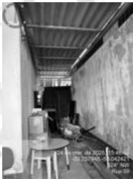
Figura 13: telhado que será substituído, novo telhado Tipologia T1 no detalhamento arquitetônico;
