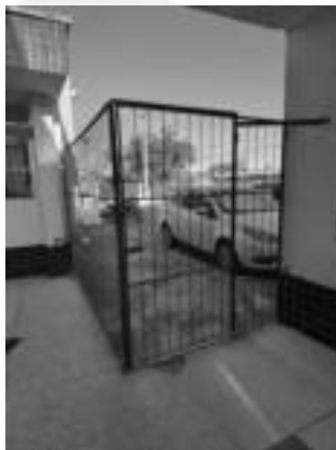
Figura 25: portão que será substituído pela tipologia PT3 no detalhamento arquitetônico
