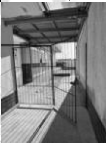
Figura 24: portão que será substituído pela tipologia PT4 no detalhamento arquitetônico
