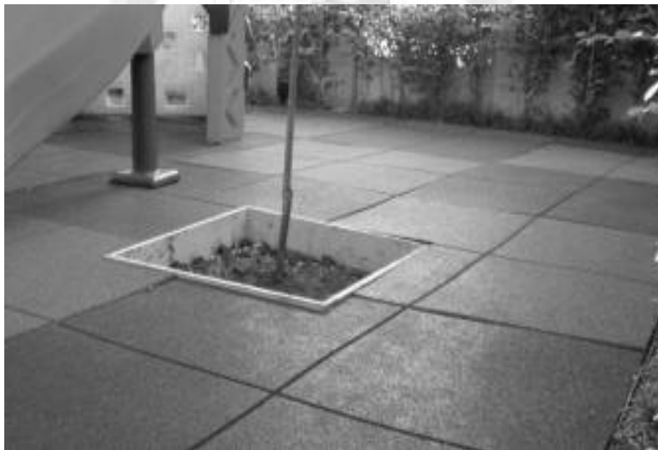
Figura 21: Detalhe ilustrativo do piso de borracha
