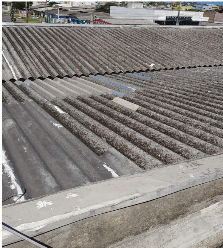
Figura 41: Detalhe da cobertura da escola
