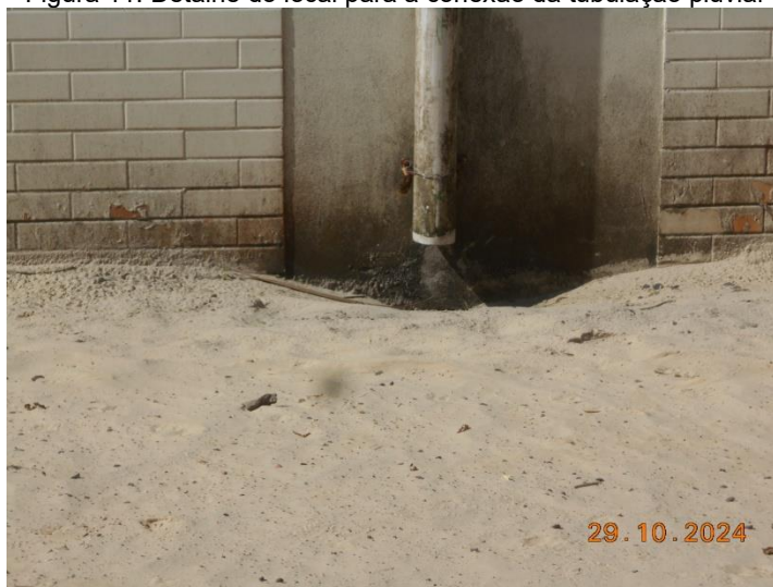
Figura 11: Detalhe do local para a conexão da tubulação pluvial
