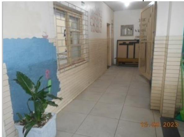
Figura 22: Detalhe do revestimento externo nas paredes da Secretaria
