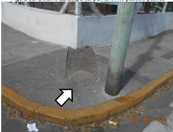
Figura 08: Detalhe da tampa da CORSAN no passeio público
