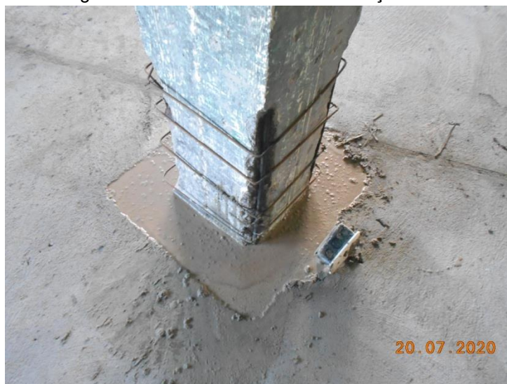
Figura 36: Detalhe do estribo de reforço colocado
