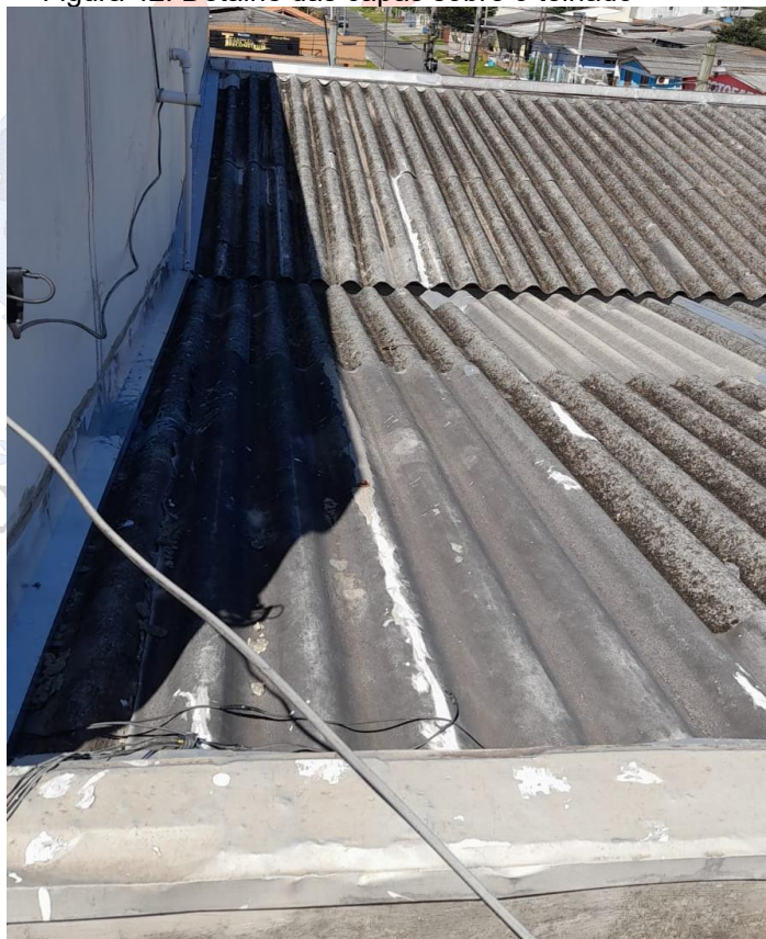
Figura 42: Detalhe das capas sobre o telhado
