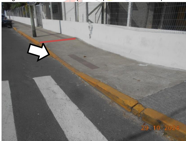
Figura 06: Detalhe da via pública e passeio na via da esquina da escola
