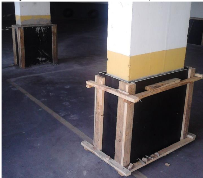
Figura 38: Modelo de forma com compensado Naval
