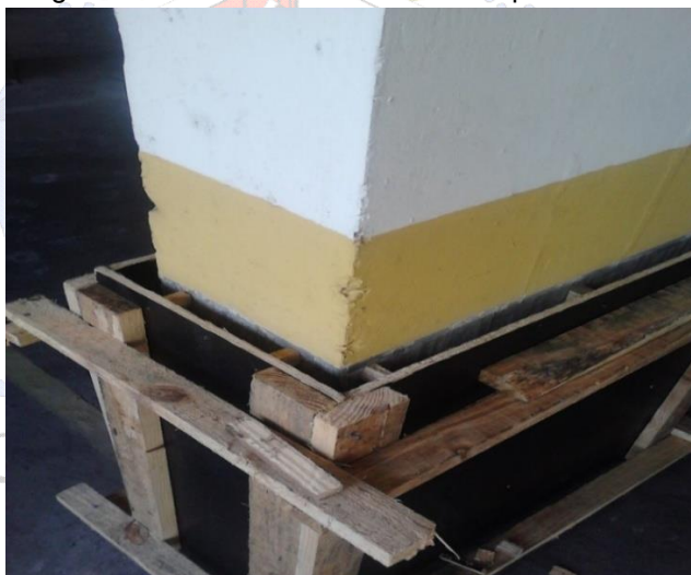
Figura 37: Modelo de forma com compensado Naval
