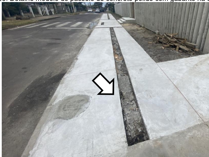
Figura 09: Detalhe modelo do passeio de concreto polido com gabarito na execução
