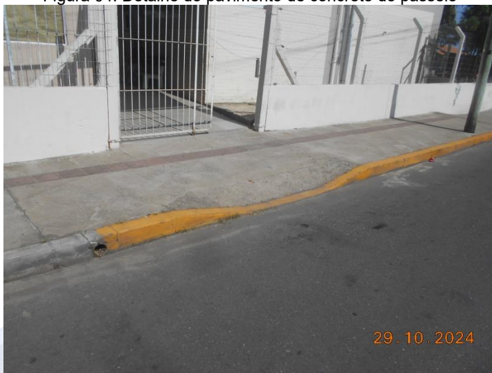
Figura 04: Detalhe do pavimento de concreto do passeio
