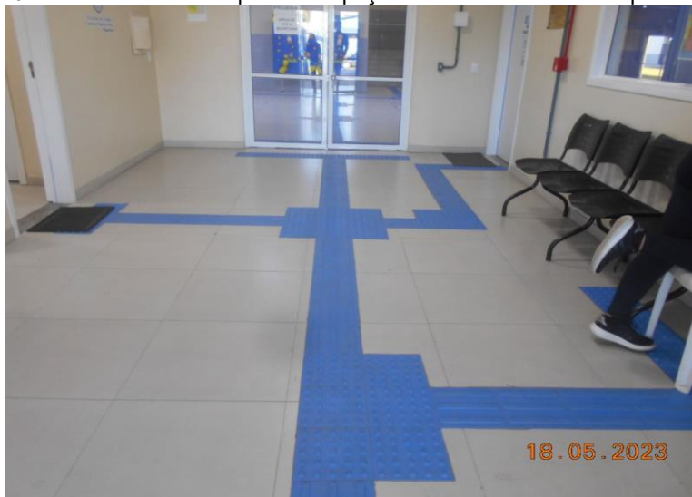
Figura 02: Detalhe do modelo padrão de peças de borracha sobre a superfície do piso
