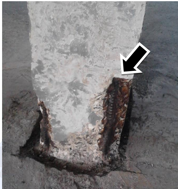
Figura 35: Detalhe do produto protetor de armadura aplicado
