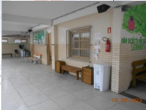
Figura 24: Detalhe do revestimento externo nas paredes da Secretaria
