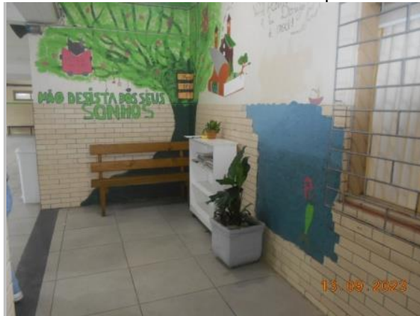
Figura 23: Detalhe do revestimento externo nas paredes da Secretaria
