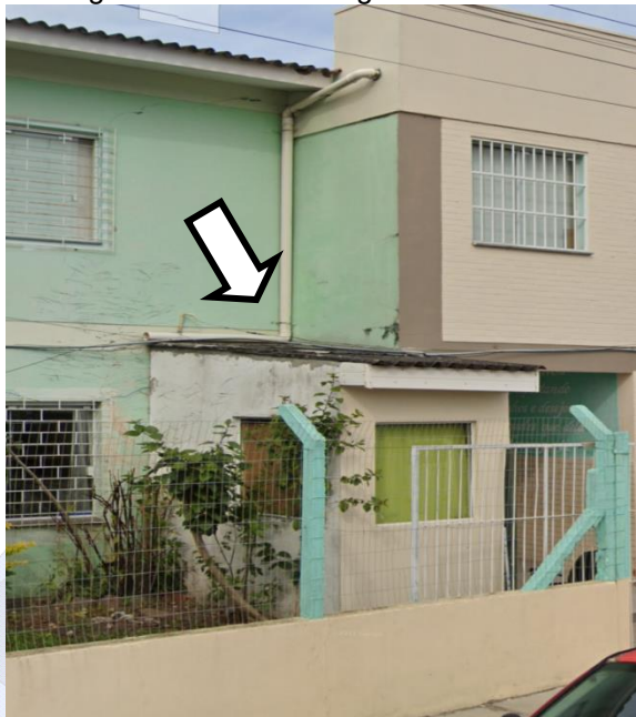
Figura 45: Detalhe da guarita da escola
