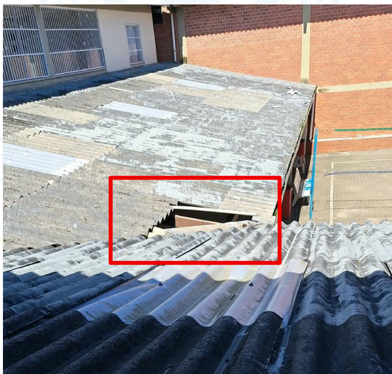
Figura 5 – Local para reposição das telhas
