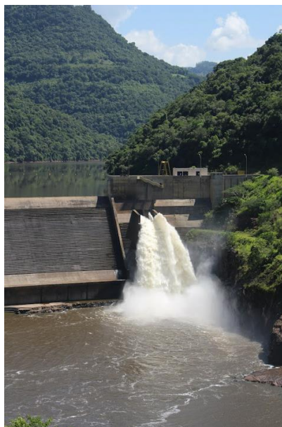
Figura 5 – Usina Hidrelétrica Castro Alves – CERAN (Progressiva 21.000 km desde UHE Castro Alves)
