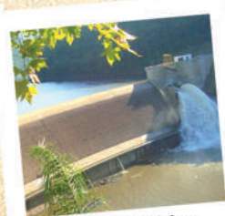
08 Mirante Usina Hidroelétrica Castro Alves
