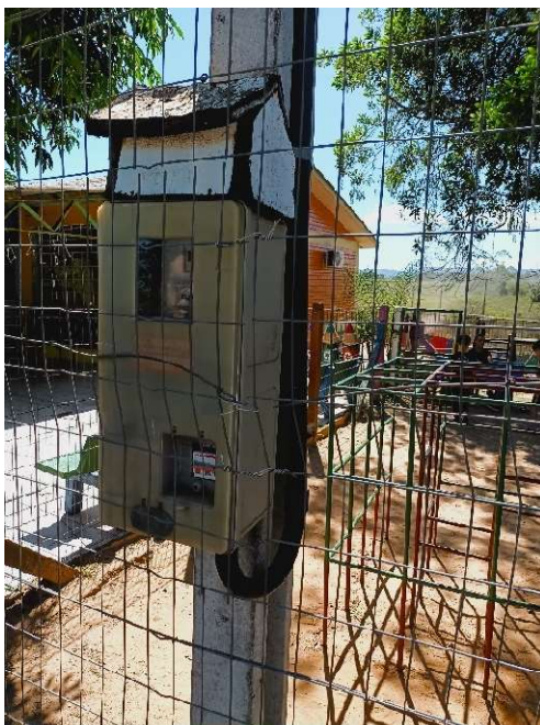
a) Quadro de medição b) disjuntor geral (63A) Figura 6: Quadro de medição EMEF SÃO PEDRO
