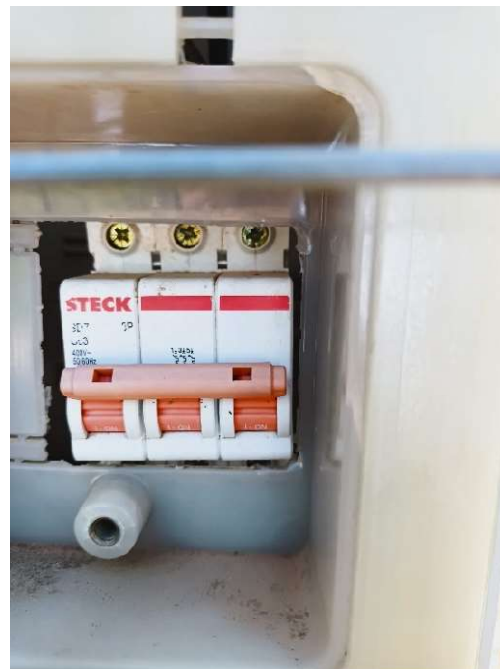
a) Quadro de medição b) disjuntor geral (63A) Figura 6: Quadro de medição EMEF SÃO PEDRO
