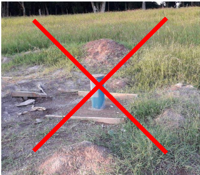
Poço sem cercamento.
