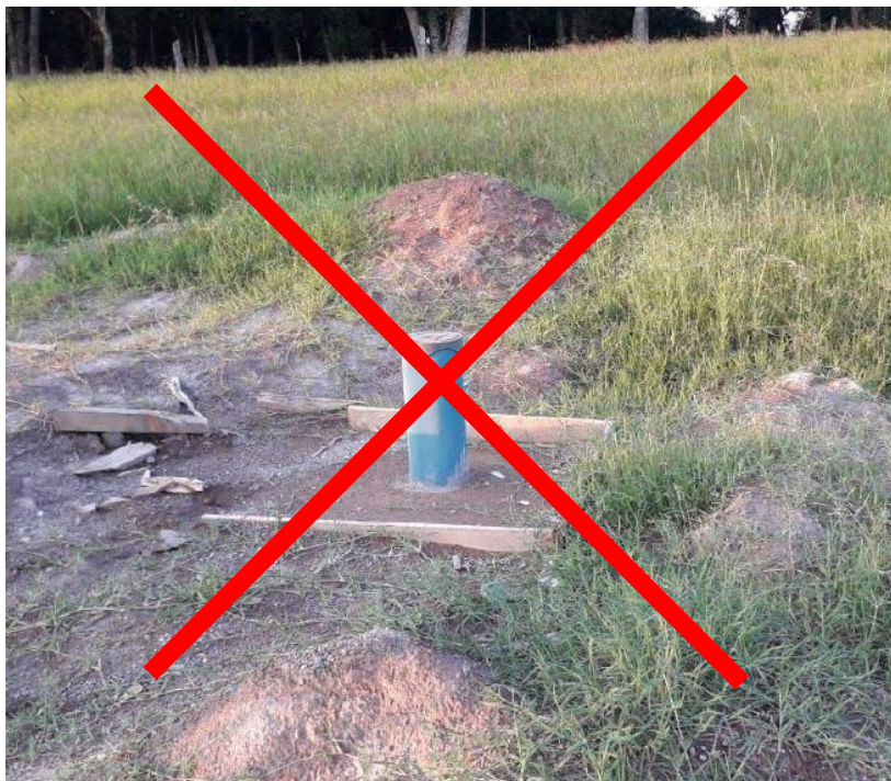
Poço sem cercamento.
