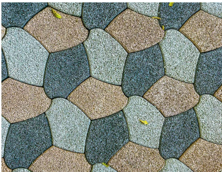
Imagem do piso drenante
