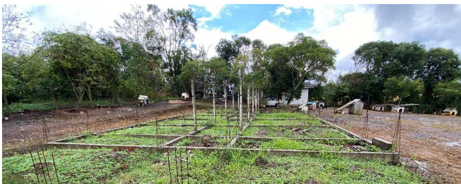
Imagem 1- Vista da estrutura existente que será aproveitada nesta etapa da obra.
