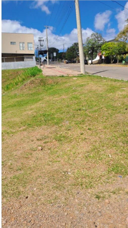
Figura 2 - Ausência de passeio público
