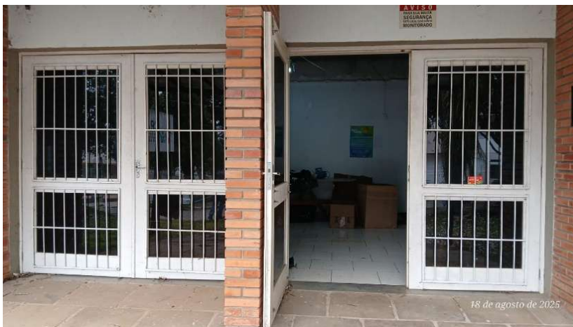
FOTO 2: Portas no acesso da edificação no pav. térreo.
