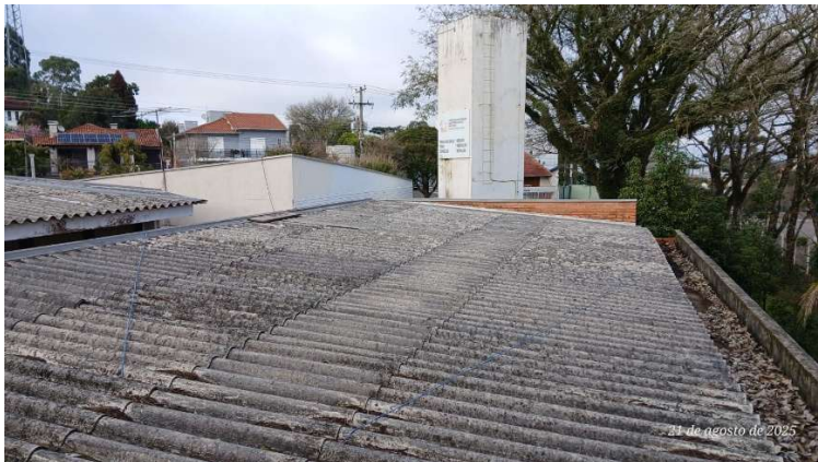
FOTO 12: Telhado existente em fibrocimento.
