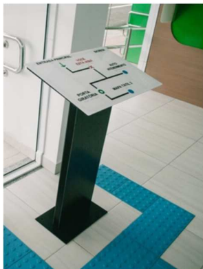
Figura 2 - Imagem representativa do Mapa tátil e da sinalização em seu entorno conforme NBR16537/24.
