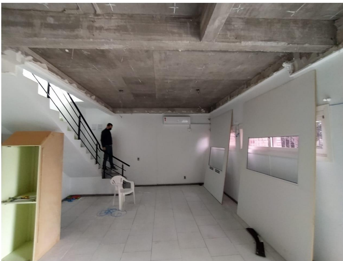
Figura 1 - Visão Geral da estrutura atual- pavimento térreo/interno.
