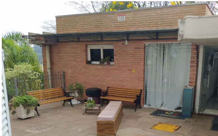
FOTO 13: Vista do acesso direto ao segundo pavimento pela Rua Francisco Schneider.
