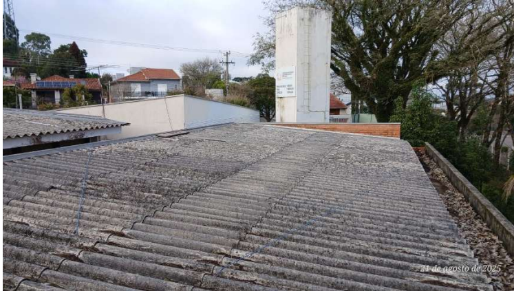
FOTO 12: Telhado existente em fibrocimento.
