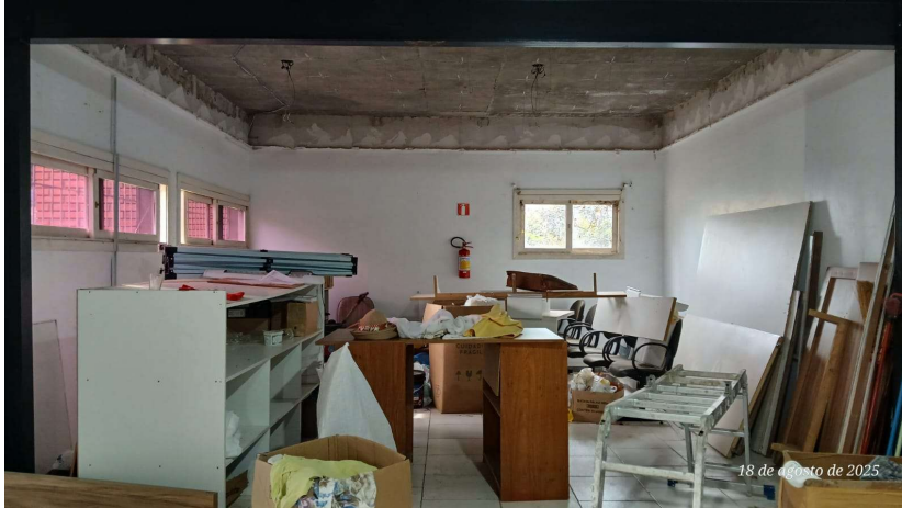
FOTOS 4 E 5: Pavimento térreo.
