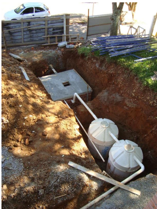
Figuras 8 e 9 – Fotos da época da execução da obra e correspondente sistema de tratamento de efluentes instalado.
