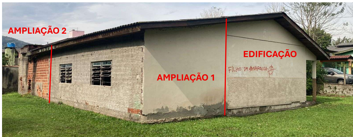
Imagem 01 - Fachada oeste, ampliação 1.
