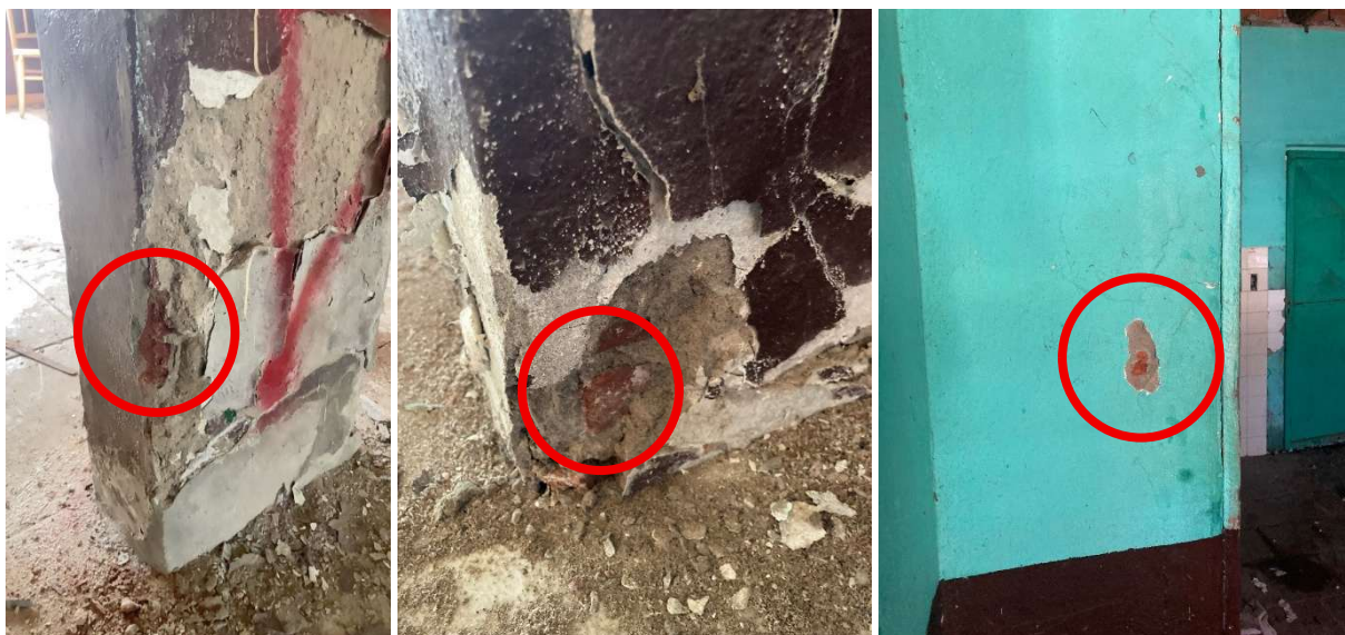
Imagem 03 – Inspeção de potenciais pilares.
