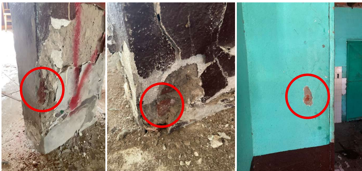
Imagem 03 – Inspeção de potenciais pilares.
