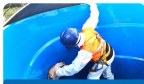
Limpeza de caixas d'água
