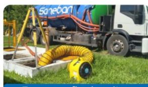
Espaço confinado e altura (NR 33 e NR 35)
