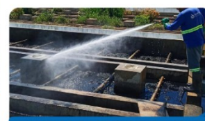
Limpeza da Estação de Tratamento de Esgoto com Hidrojateamento
