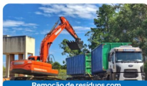
Remoção de resíduos com retroescavadeiras, escavadeiras hidráulicas, bobcat
