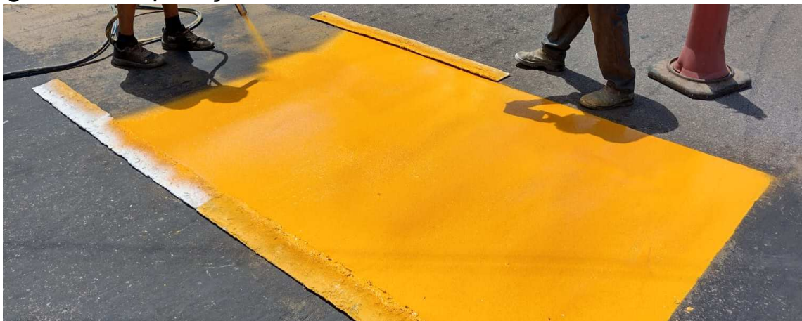
Figura 07 – Aplicação da tinta amarela em área de teste.
