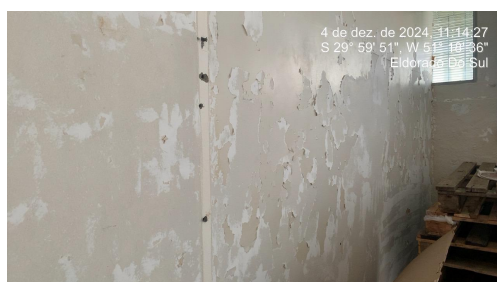
Figuras 15, 16, 17 e 18 - detalhe das paredes descascadas pela umidade.
