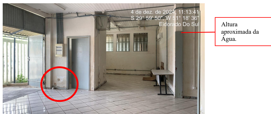
Figura 14 - Vista 2 - Identificada em Planta (Figura 4). Paredes manchadas com alguns pontos descascando, conforme indicado.
