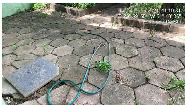
Figura 25 e 26 - Pavimentação pedras soltas.
