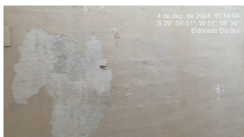
Figura 14 - Vista 2 - Identificada em Planta (Figura 4). Paredes manchadas com alguns pontos descascando, conforme indicado.
