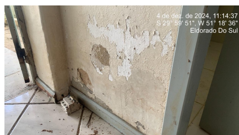
Figura 14 - Vista 2 - Identificada em Planta (Figura 4). Paredes manchadas com alguns pontos descascando, conforme indicado.
