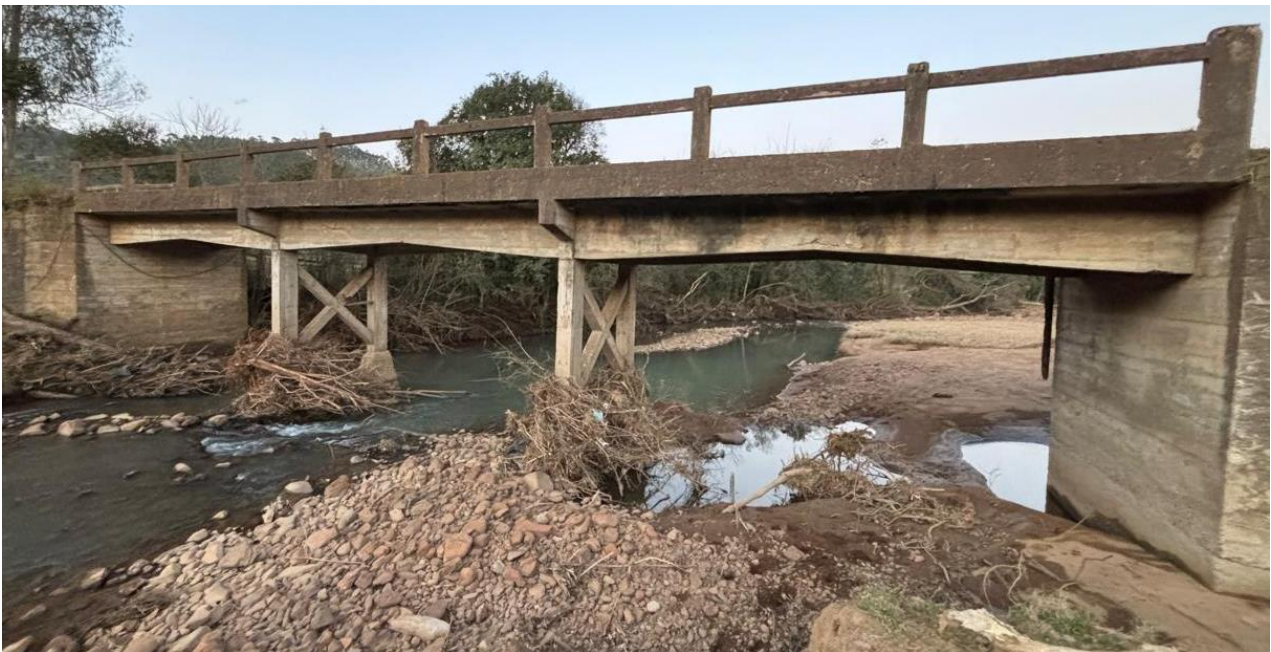
Fotografia 1: Vista geral da ponte sobre o Arroio Coqueiro. Coordenadas: 29° 09' 58" S / 52° 04' 38" O. Fonte: Prefeitura Municipal de Relvado/RS.
