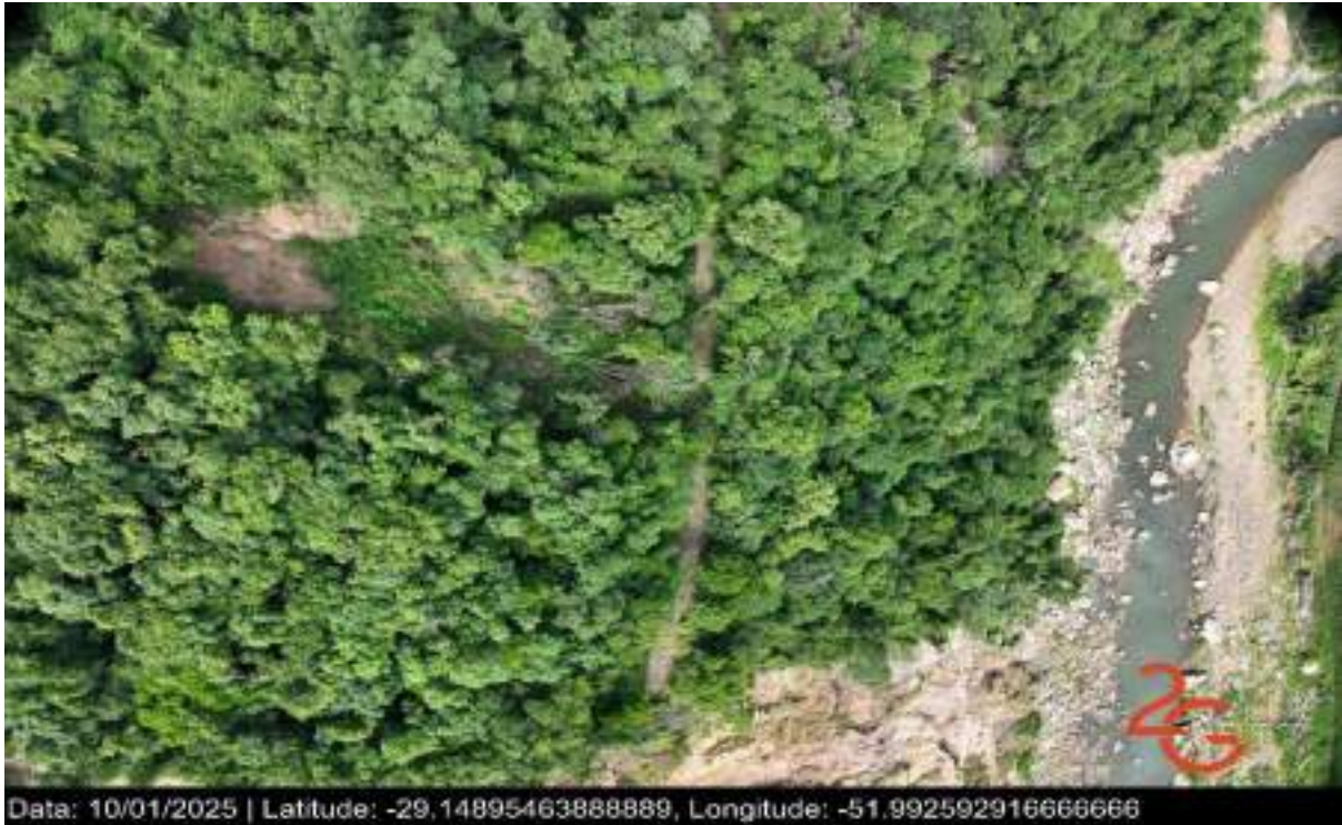
Imagem 12: queda de barreira em via, a desobstruir, não contabilizada nas metas anteriores. Coordenadas: latitude -29.148954° e longitude -51.992592°. Data: 10/01/2025. Fonte: 2G Topografia.
