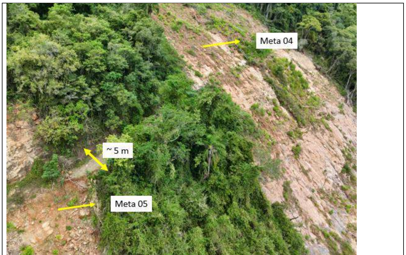
Figura 3a: Foto aérea da Meta 05 imediatamente antes da ocorrência
