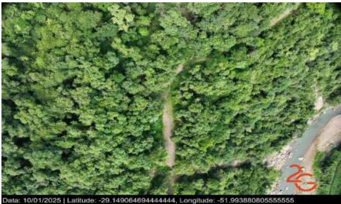
Imagem 13: estrada obstruída por desmoronamento do talude a jusante. Coordenadas: latitude -29.149064° e longitude -51.993880°. Data: 10/01/2025. Fonte: 2G Topografia.
